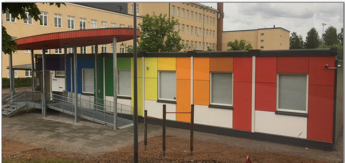
Kuva 15. Maalattuja paneeleita C80-järjestelmän moduuleissa. Nekalan kirjasto. (Kuva: Mikko Keskinen)
