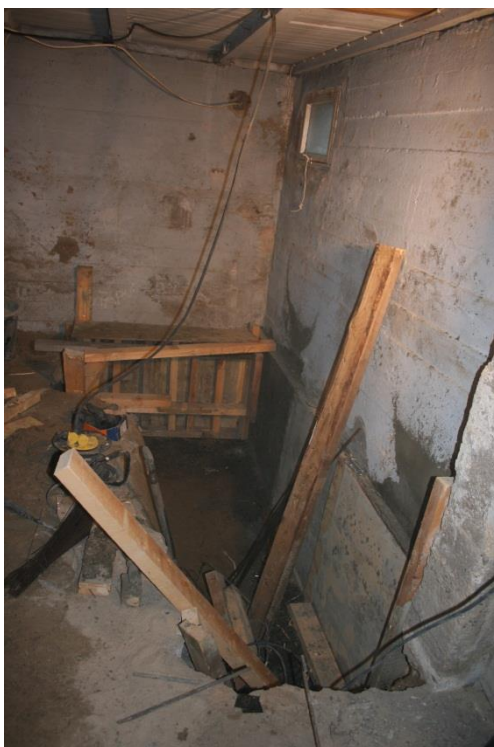
KUVA 6. Perustustyö kannattaa tehdä pienissä osissa
