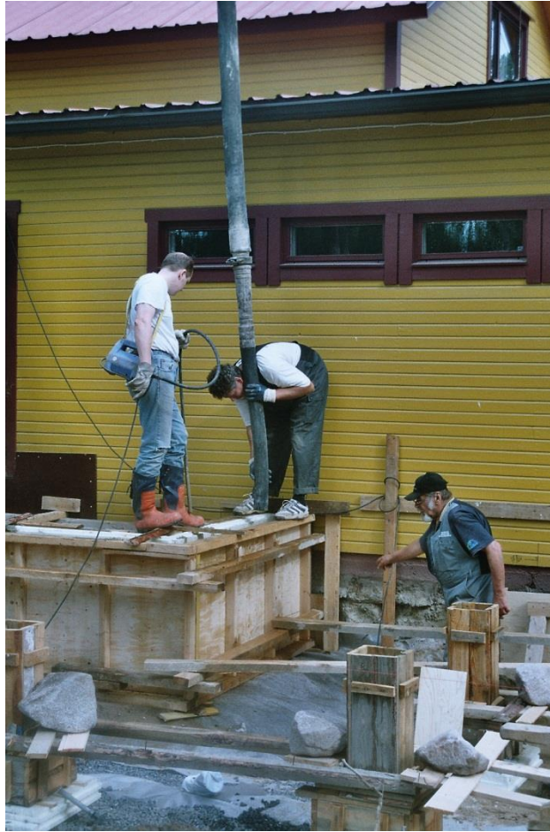
KUVA 4. Korjausrakentaminen edellyttää monipuolista osaamista
