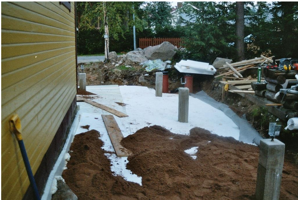
KUVA 9. Routaeristys on osa järjestelmällistä korjaamista
