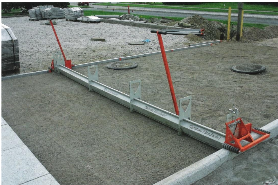
Kuva 7. Asennushiekan levittämistä (Öhrnberg ym. 2006, 54).
