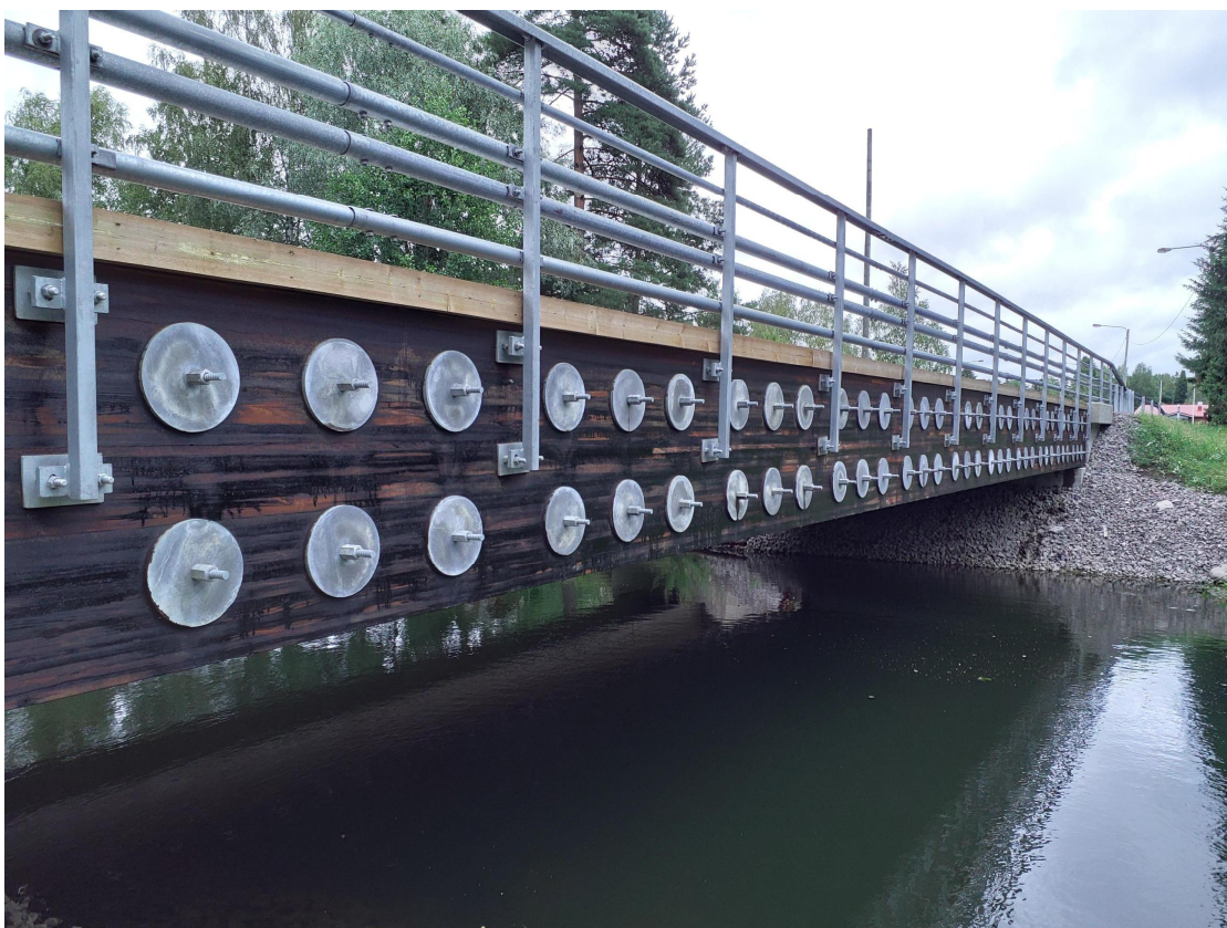
KUVA 4: Puinen laattasilta, Kylä-Peron silta. (Taitorakennerekisteri: Milla Malka, Sitowise Oy 2021)
