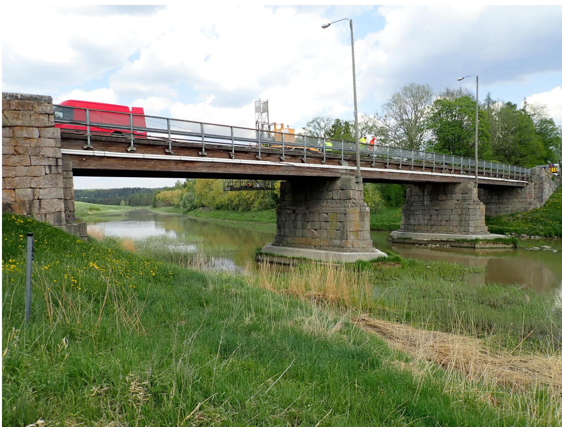
KUVA 9. Liimapuinen palkkisilta, yleiskuva sivusta.
