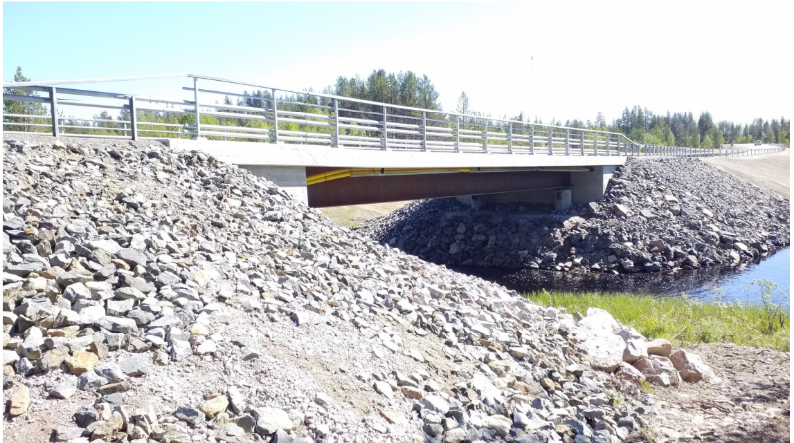
KUVA 6: Liittorakenteinen teräspalkkisilta, betonikansi, Äijäjoen silta. (Taitorakennerekisteri: Jukka Leskelä, Inspecta Oy 2019)
