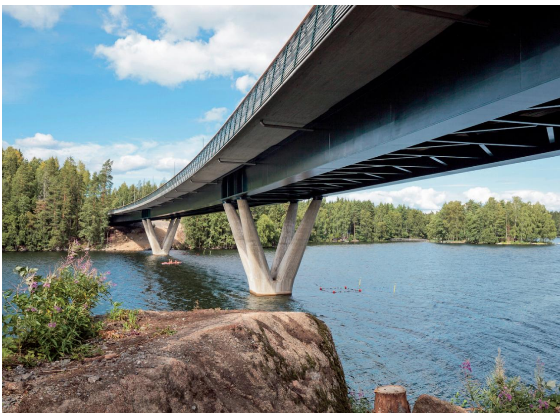
KUVA 12. Kuva liittorakenteisesta teräspalkkisillasta. (Betoni-lehti 3/2015, 69).
