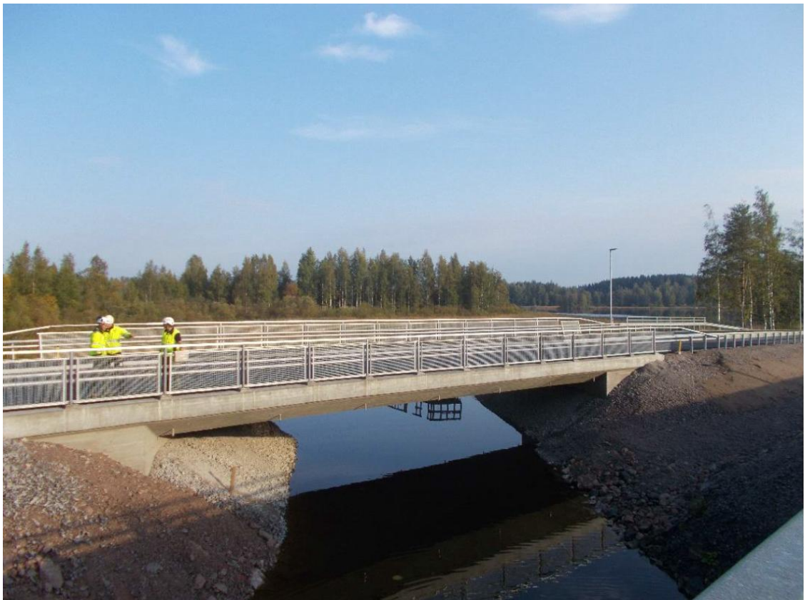
KUVA 8: Betonisilta, Pistesalmen silta. (Taitorakennerekisteri: Veikko Wallin, Welado Oy 2019)
