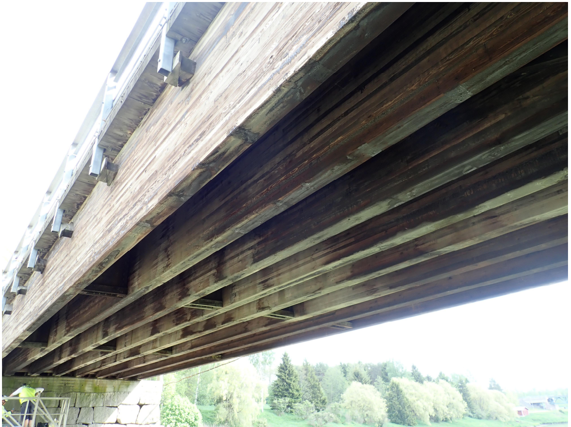
KUVA 10. Liimapuinen palkkisilta sillan alta kuvattuna.
