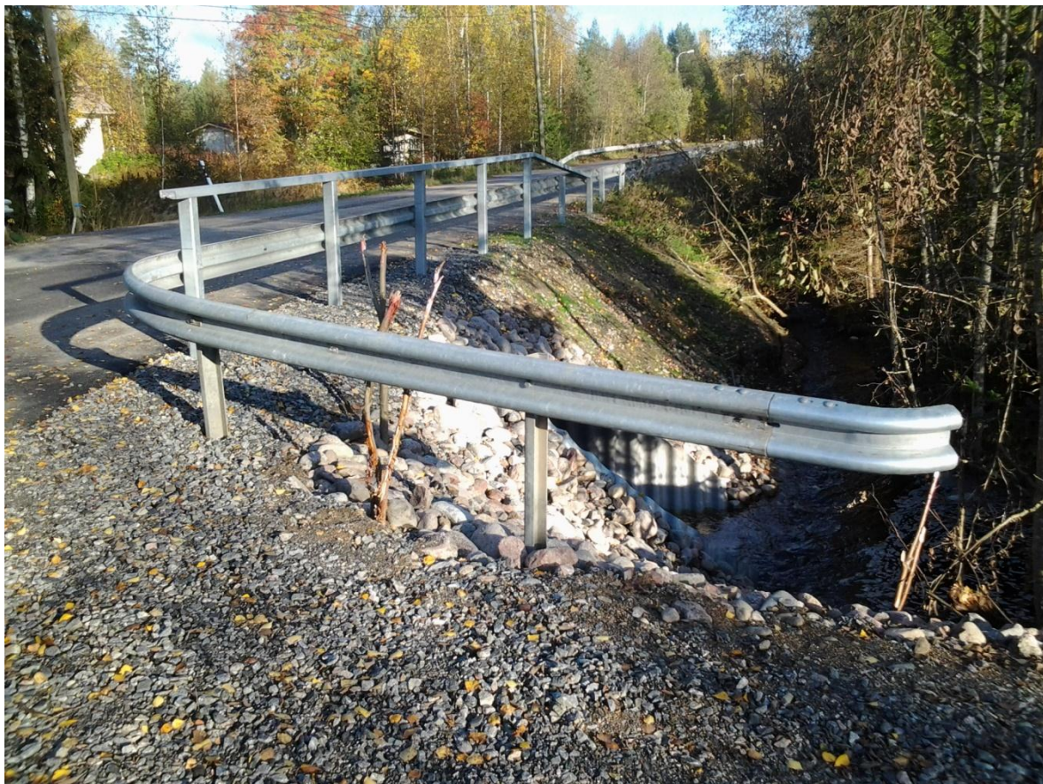
KUVA 10. Kuva Kohisevanpuron putkisillalta. Uudet kaiteet sekä taustalla näkyy putken päähän tehty molskottiverhous. (Taskinen 2013-9-23).
