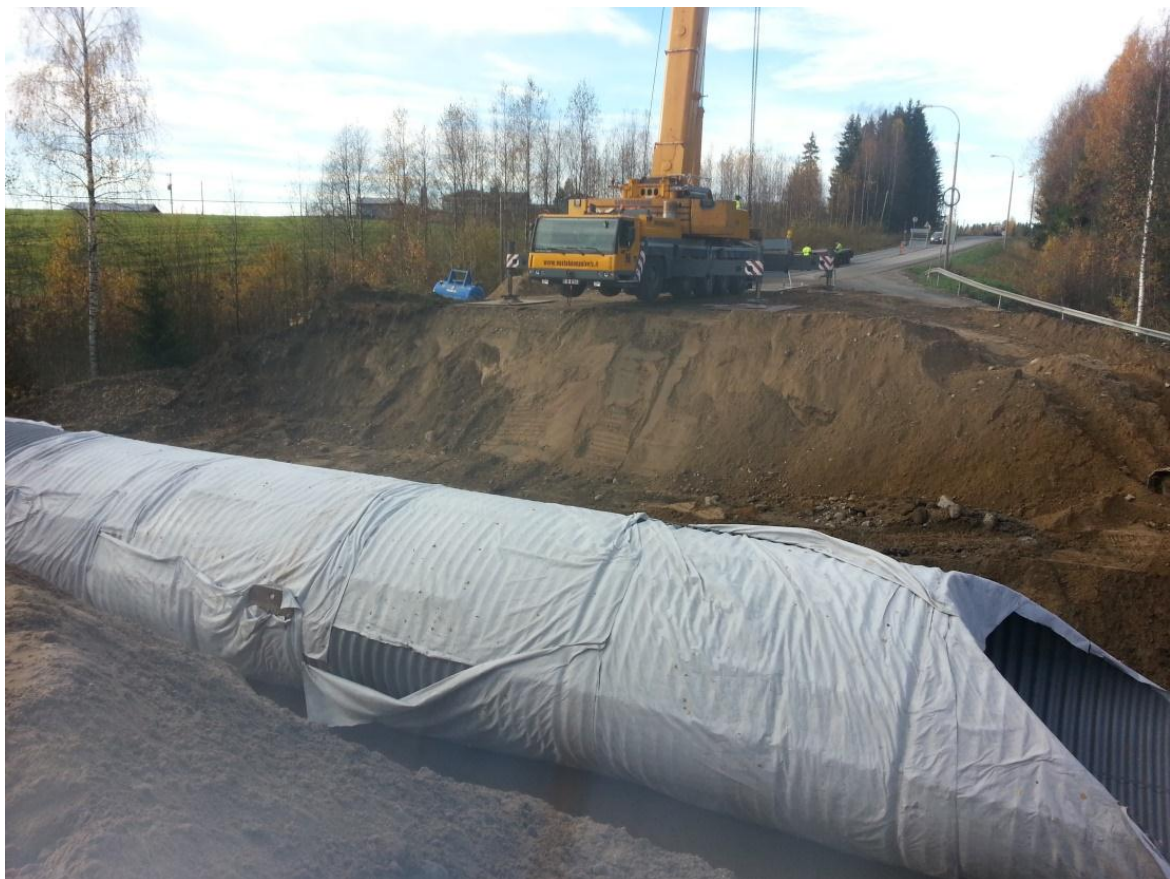
KUVA 6. Kuvassa kaivantoon laskettu teräsputki silta sekä nostotyön suorittanut nosturi. (Leskinen 2013-11-10).
