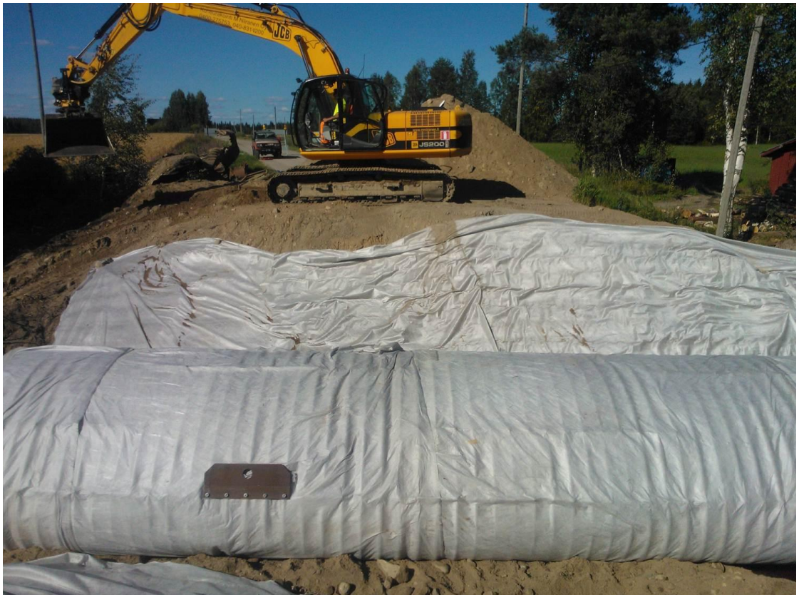
KUVA 5. Nostokorvakkeet kiinnitettyinä putkeen (Leskinen 2013-11-10).
