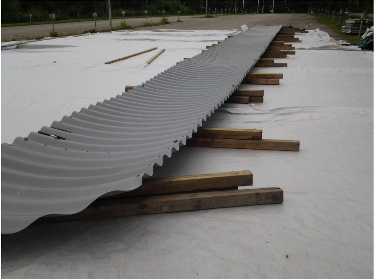
KUVA 4. Kuvaa kasaus paikalta. Putkisiltaa aloitettiin kasaamaan kokoamalla alimmat palat puiden päälle. Alle on laitettu valmiiksi myös suodatinkangas, joka pyöräytetään sitten lopulta putken ympärille. (Taskinen 2013-7-18.)
