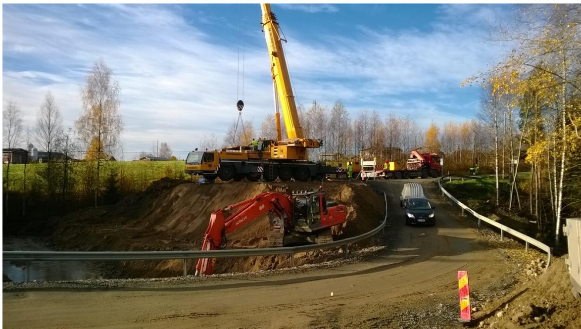
KUVA 7. Kauppisenjoen putkisilta. Liikenteelle tehtiin kiertotie. (Leskinen 2013-11-10).
