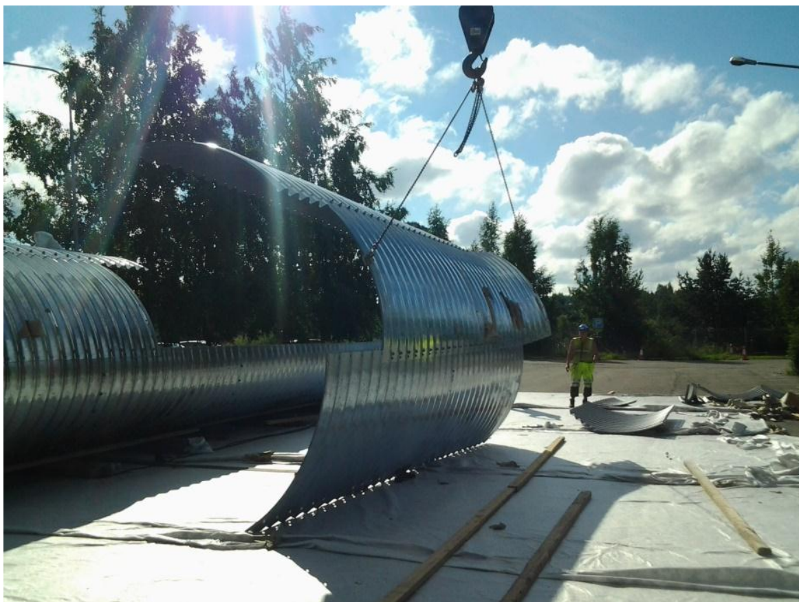
KUVA 3. Putken yläpuolinen puolikas nostettiin vieressä olevan putken alaosan päälle (Taskinen 2013-7-20).
