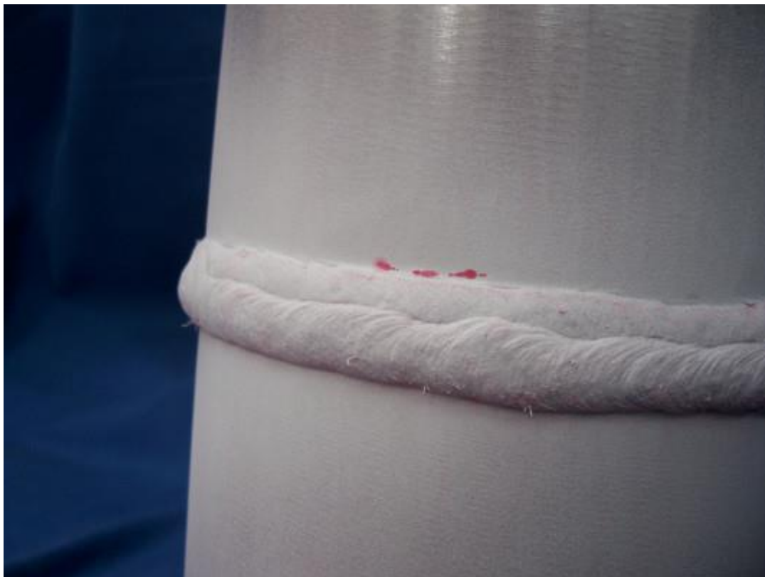
Kuva 11. Tunkemanestetarkastuksella havaittu virhe. (Non-Destructive Academy of S.A:n www-sivut )
