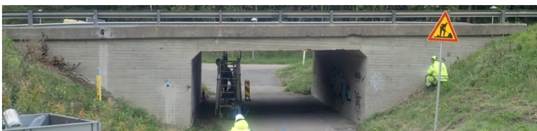
KUVA 3. Teräsbetoninen kehäsilta (Ramboll Finland Oy 2021)
