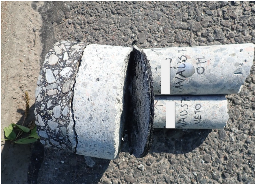
KUVA 7. Pintarakenteiden arviointi (Viippo 2021)
