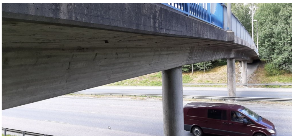
KUVA 2. Teräsbetoninen jatkuva ulokepalkkisilta (Viippo 2021)
