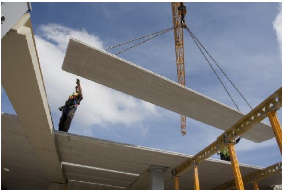
KUVA 6. Kuorilaatan asennus. (Parma Oy Matti Vuohelainen n.d. Betonitieto n.d.e. mukaan.)
