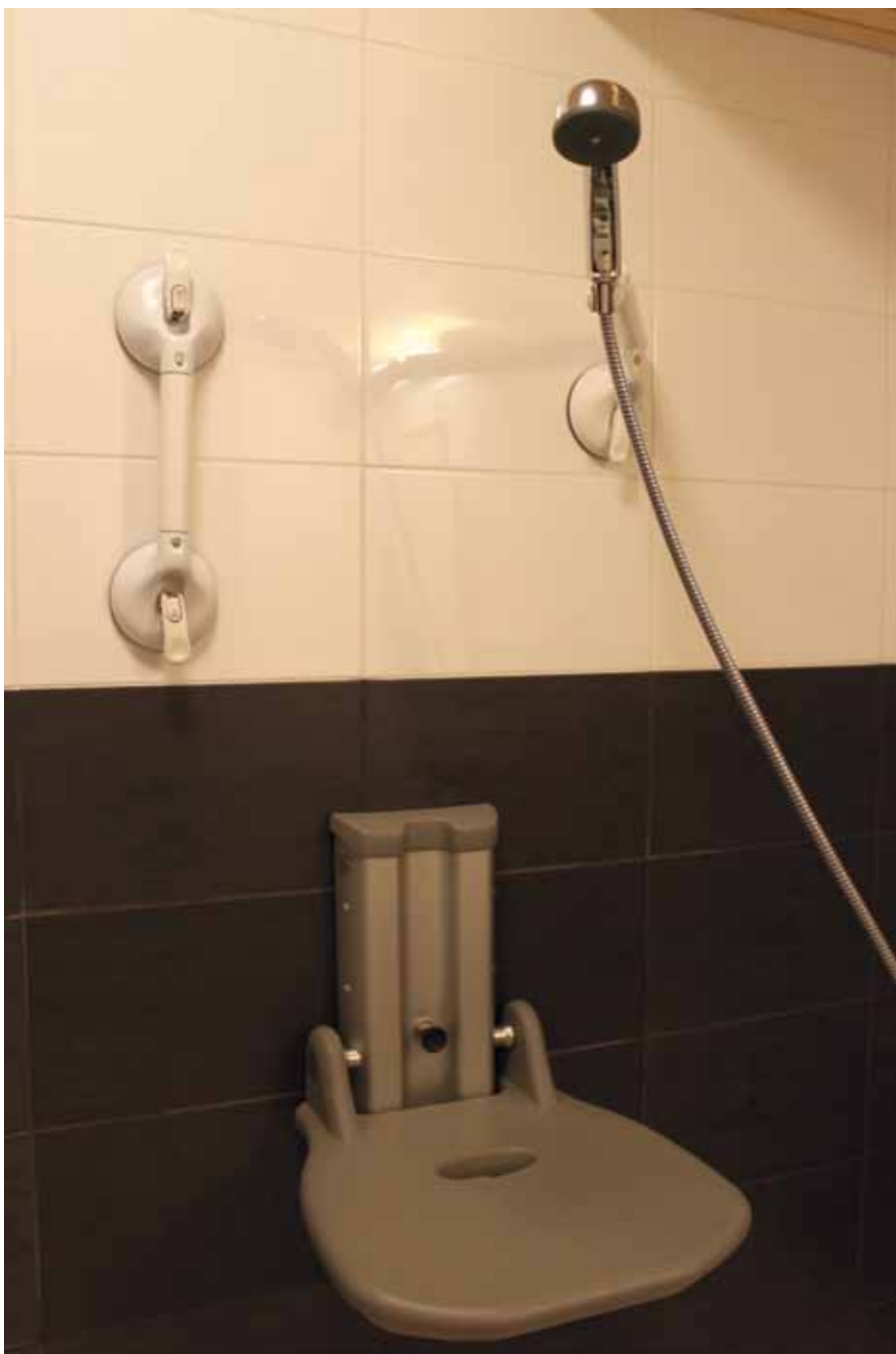
Фотография 7. Опорный поручень, держатель для душа и регулируемое по высоте сиденье облегчают процесс умывания (Фото: Ронан Браун)
