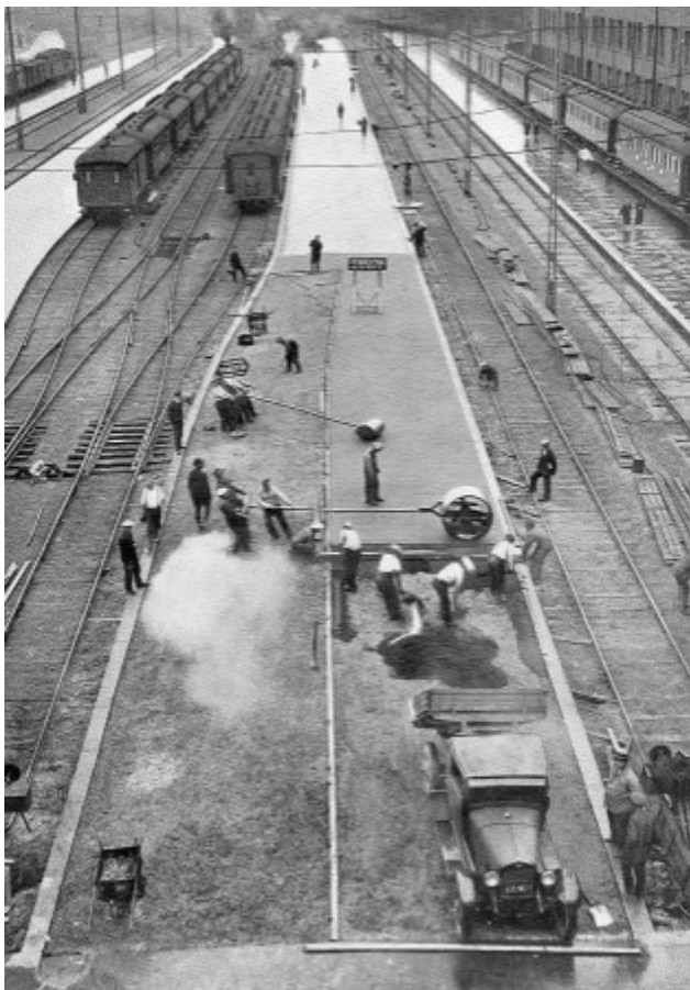
Kuva 2. Helsingin asemalaiturin päällystämistä topeka-asfaltilla vuonna 1932
