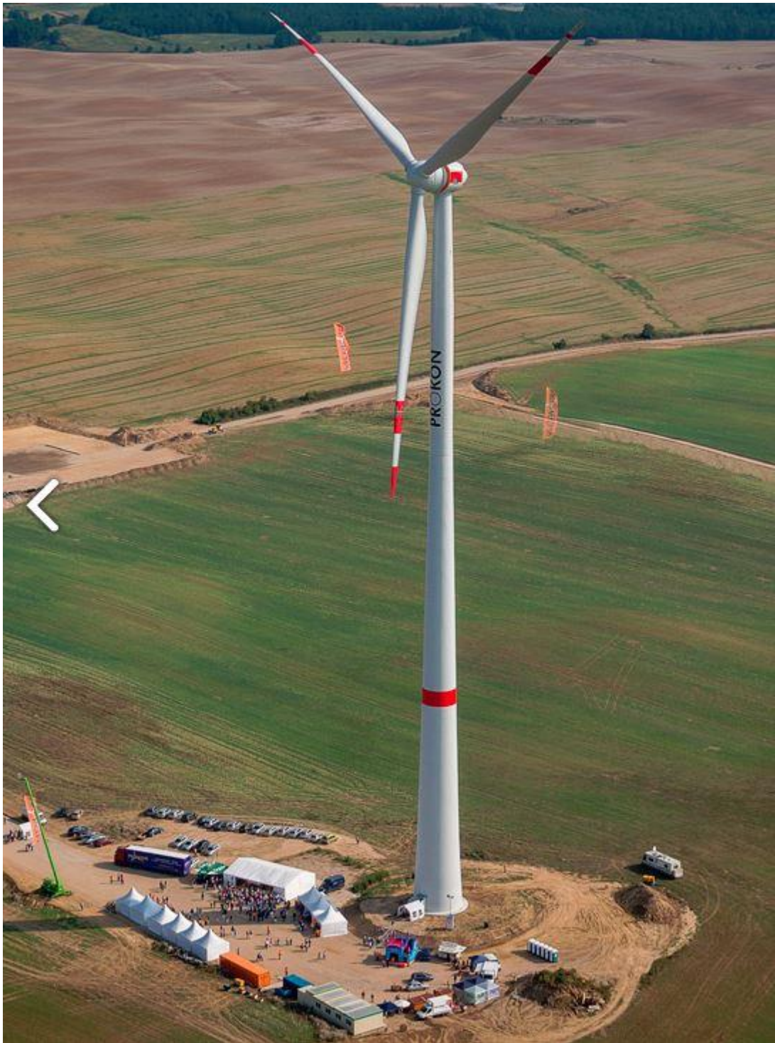
Figur 6. Prokons P3000 färdigt i Krakow augusti 2013.
