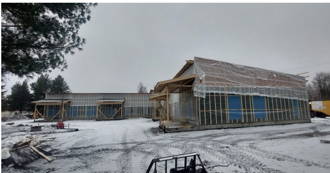
Kuva 2. Näkymä Satakruunun rakennustyömaasta etelästä päin.
