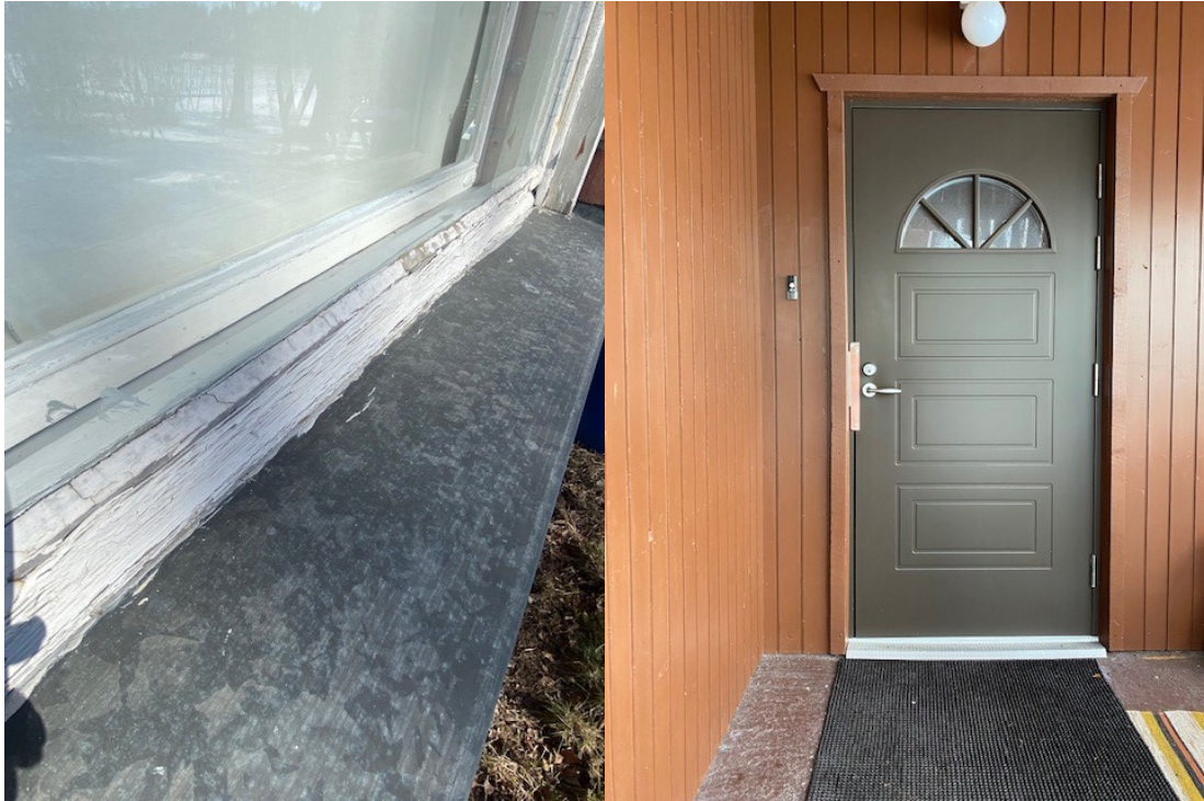
Kuva 18 ja 19. Alkuperäinen ikkuna ja uusittu ulko-ovi.
