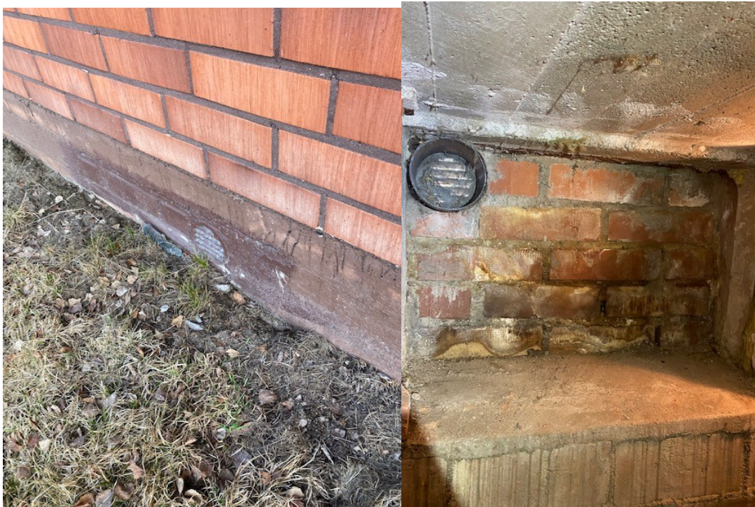
Kuva 14 ja 15. Muurattu kellarin ikkuna-aukko ulkoa ja sisältä.
