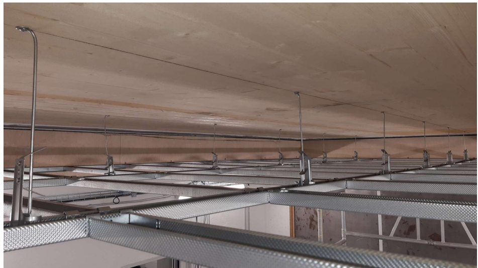
Kuva L3.9. Valokuvia alakatosta rakenteissa C2c–C11c ilman kipsilevyjä ja mineraalivillaa.
