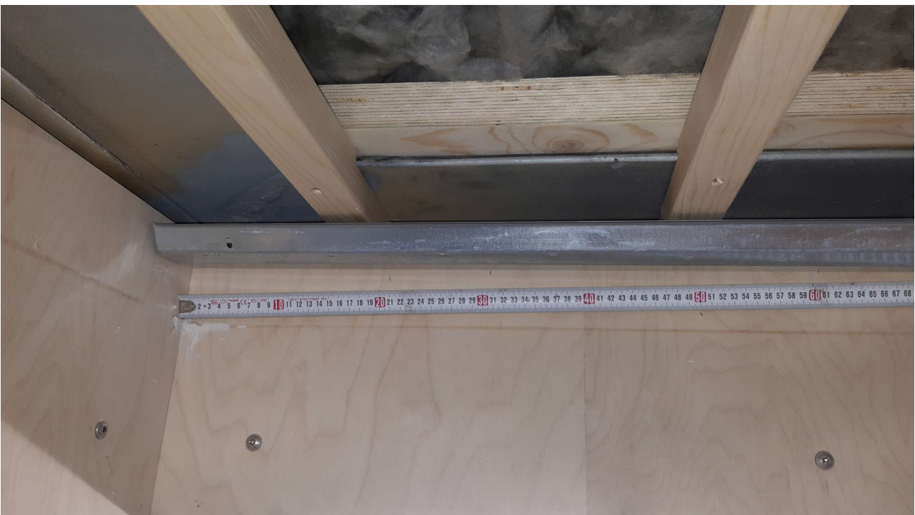
Kuva L3.8. Valokuvia alakatosta rakenteissa R2b–R11b.
