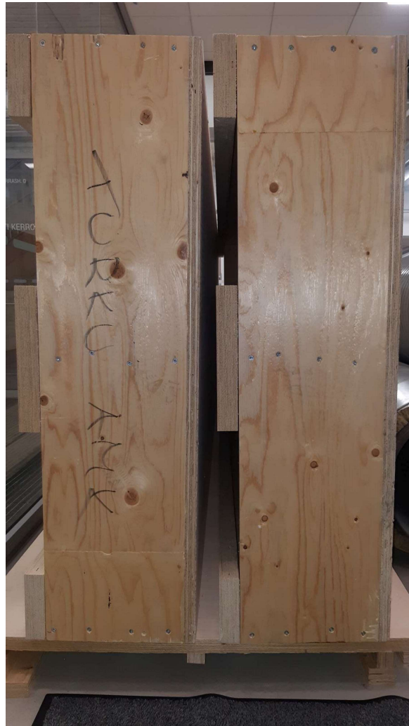
Kuva L3.13. Avokotelolaatat pystyasennossa säilytyspaikassaan. Laatan paksuus on 370 mm.
