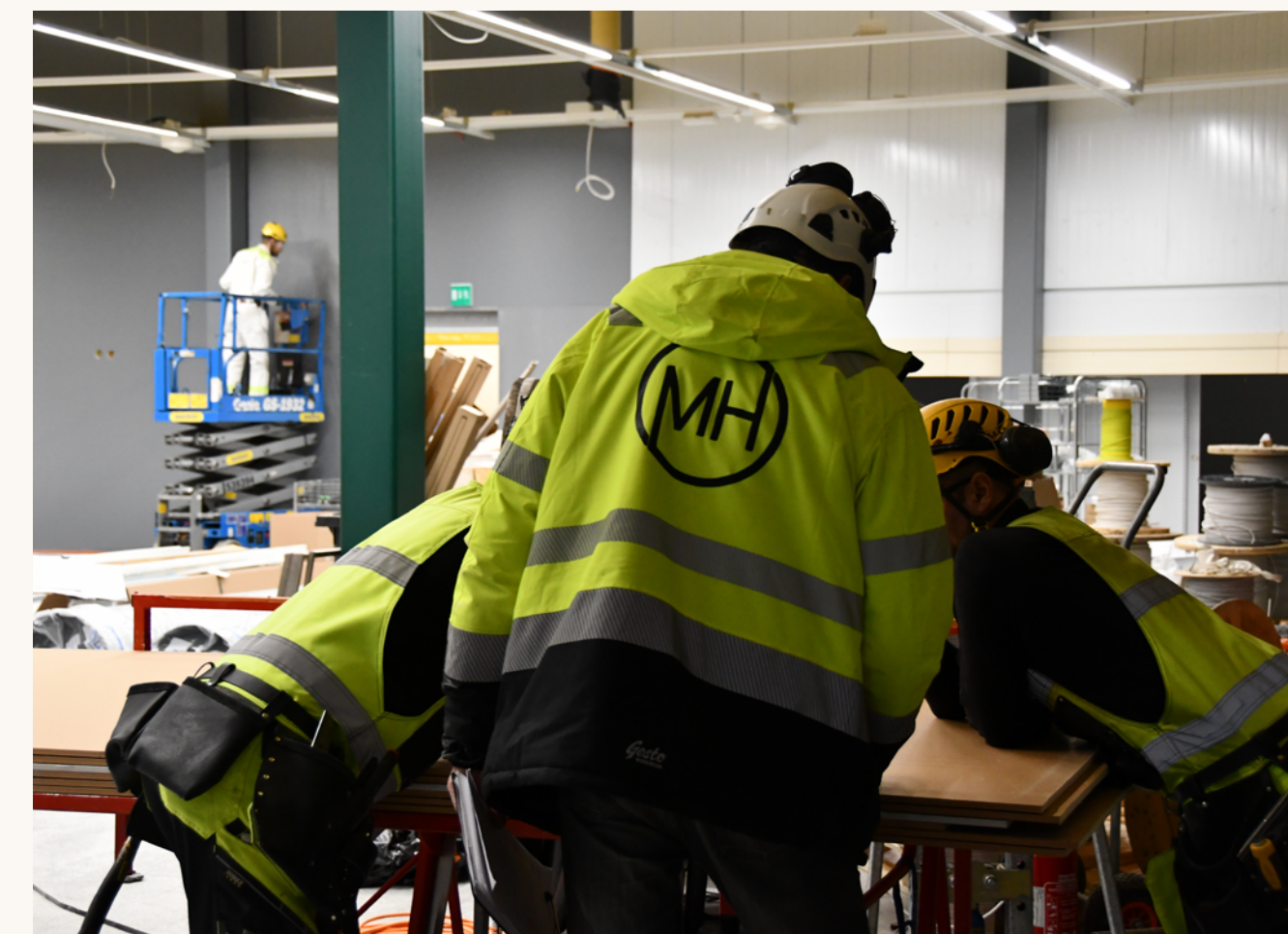
Kuva 2. MH-Rakenne Oy:n työntekijöitä työmaalla. (Kuva: Xamkin kuvapankki)
