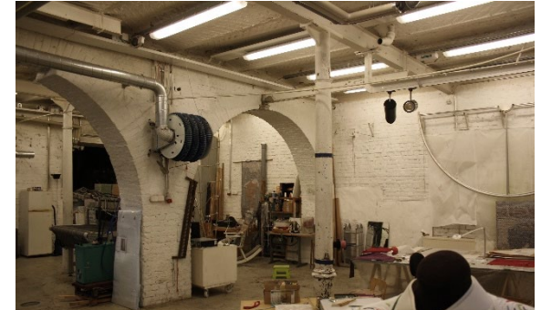
Kuva 5, Panimon varastorakennuksen osan sisätila nykyisellään.
