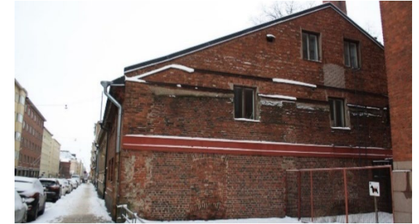
Kuva 1, Panimon varastorakennuksen osa nykytilassaan.
