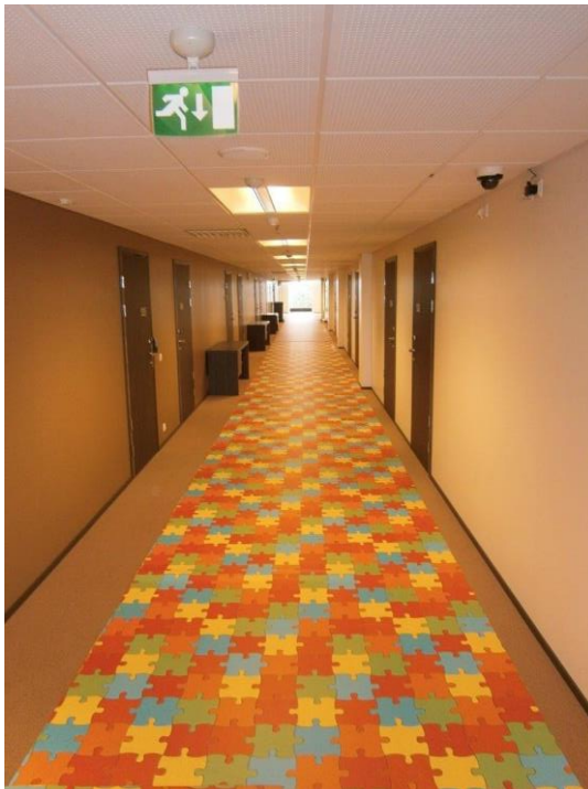
KUVA 4. Hotellin käytävä ennen osastointia
