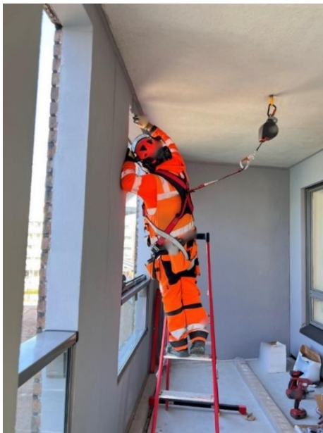
Kuva 2: Asentaja työskentelee kädet hartiatason yläpuolella ruuvatessaan ja poratessaan
