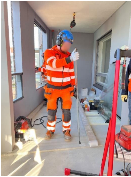
Kuva 4: Asentaja käyttää työssään apuvälinettä lasin nostamiseksi
