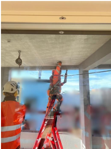
Kuva 6: Asentaja poraa betonia
