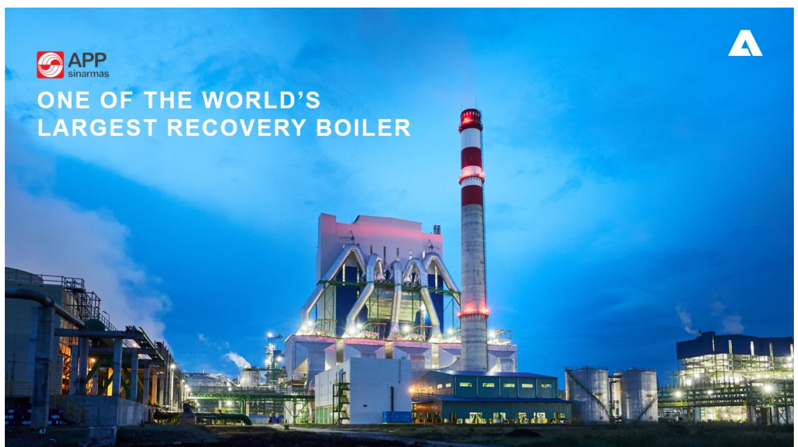
Kuva 5. OKI Pulp & Paper Mills 12000 tds/d soodakattila - Ogan Komering Ilir Regency, Indonesia. (ANDRITZ Oy, 2023.)
