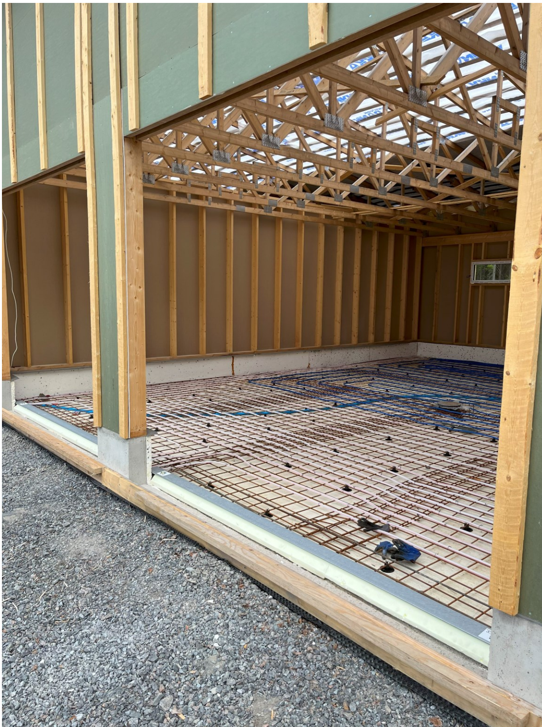
Kuva 17: Asennetut kynnykset autotallin nosto-ovien alle
