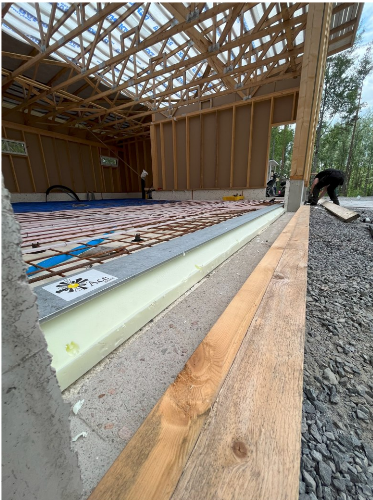
Kuva 16: Asennettu kynnys autotallin nosto-oven alle
