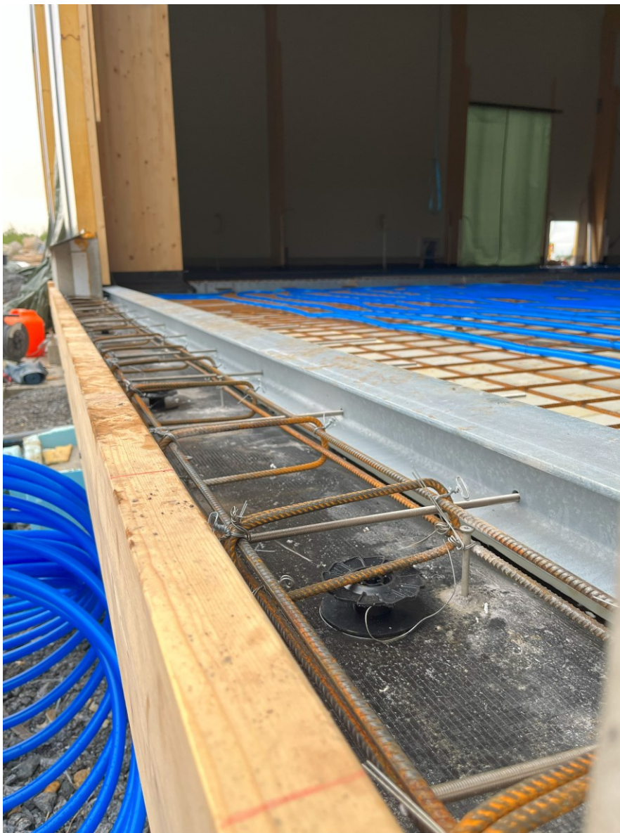
Kuva 4: Asennettu kynnyks, jossa näkyy tartuntaraidoitus.
