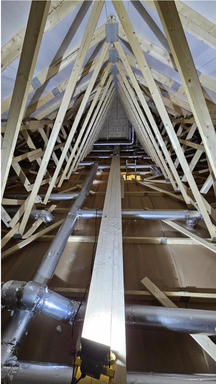
Kuva 2. Ilmanvaihtokanaviston asentaminen
