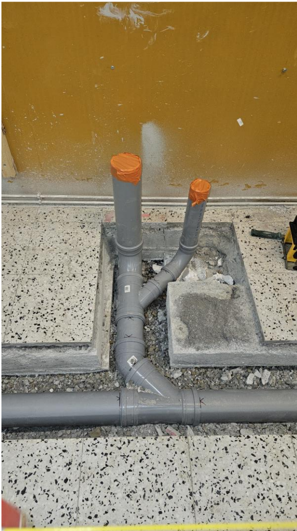
Kuva 1. Valokuva viemärin asennuksesta
