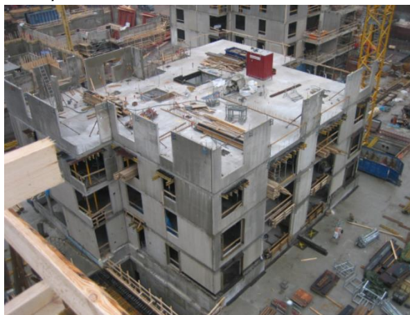
KUVA 27. Paikallavaluholvein rakennettava asuinkerrostalo. (Betonitieto.fi 2024f)
