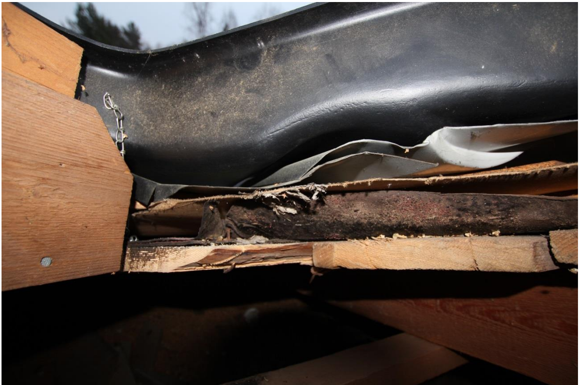
Kuva 7. Vesikaton rakenteet näkyvissä kattoluukun aukon sisäpuolelta katsottuna.
