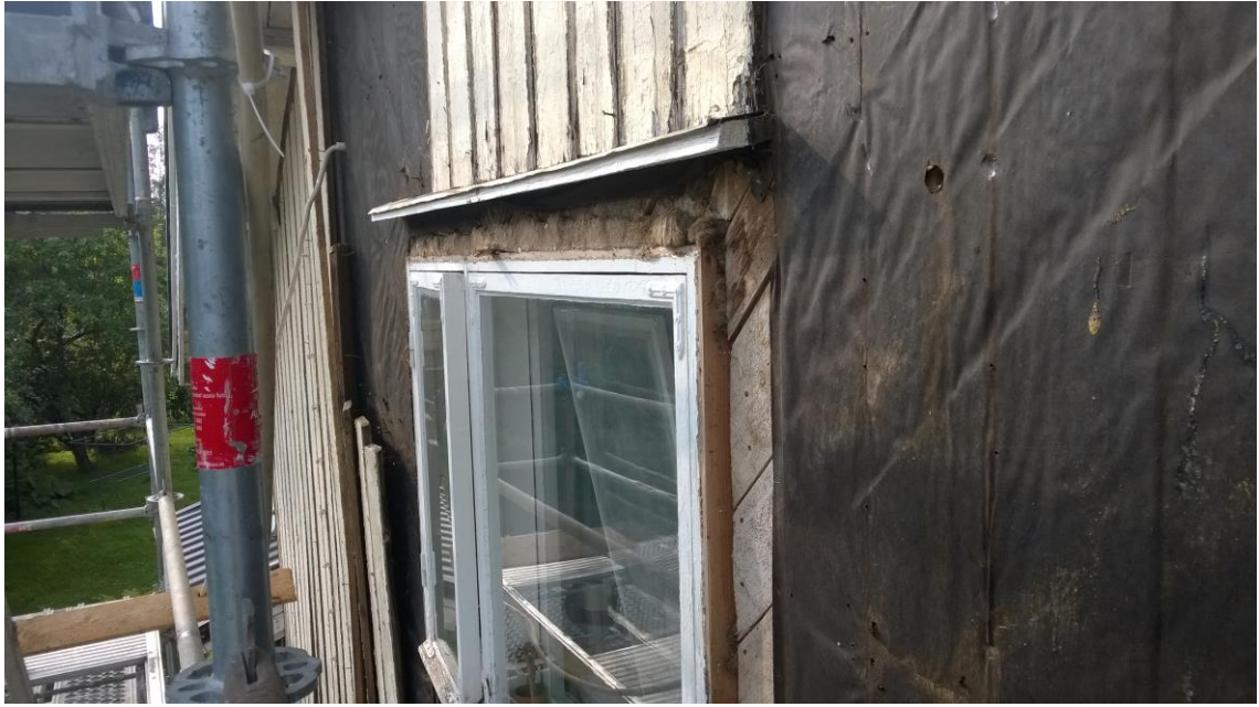
Kuva 8. Vuorilaudoituksen uusimisen yhteydessä avatut rakenteet näkyvissä.
