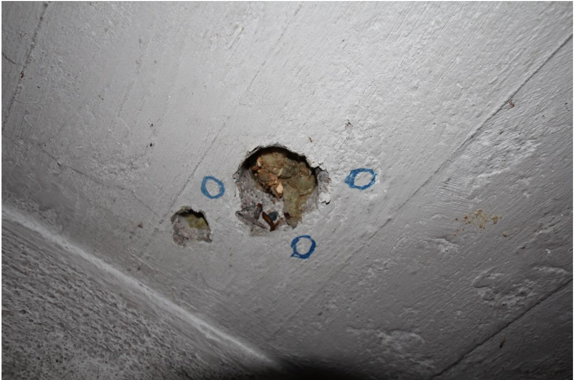
Kuva 4. Kellarin betoniholvin reikä, josta mitattiin rakenteen paksuus.
