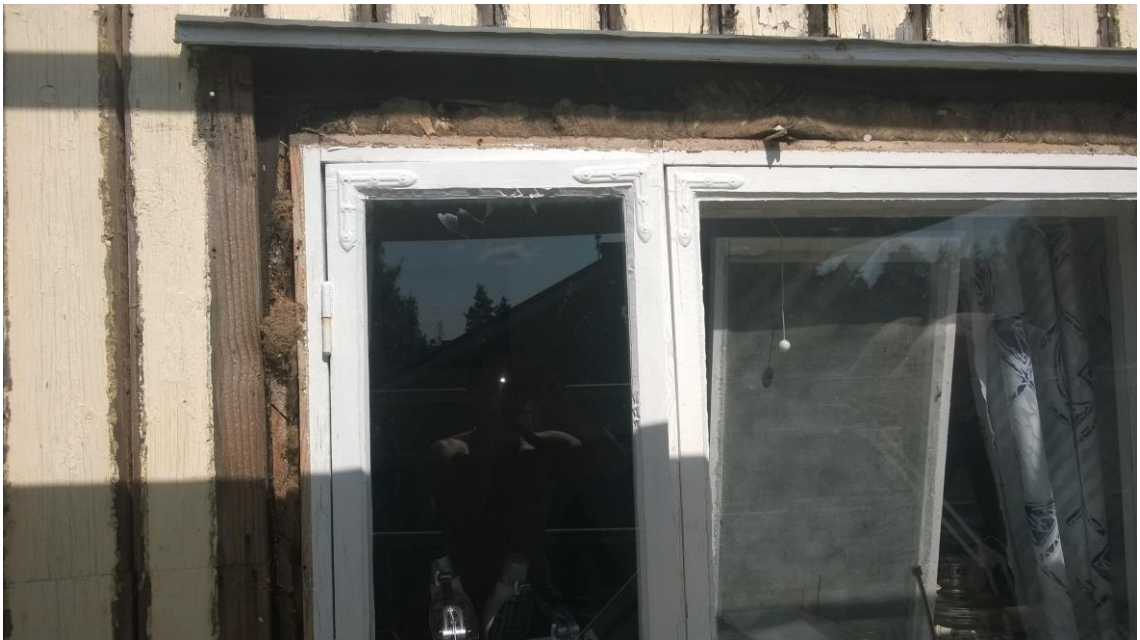
Kuva 9. Ikkunan karmiväli on tiivistetty pellava- tai hamppukuidulla.
