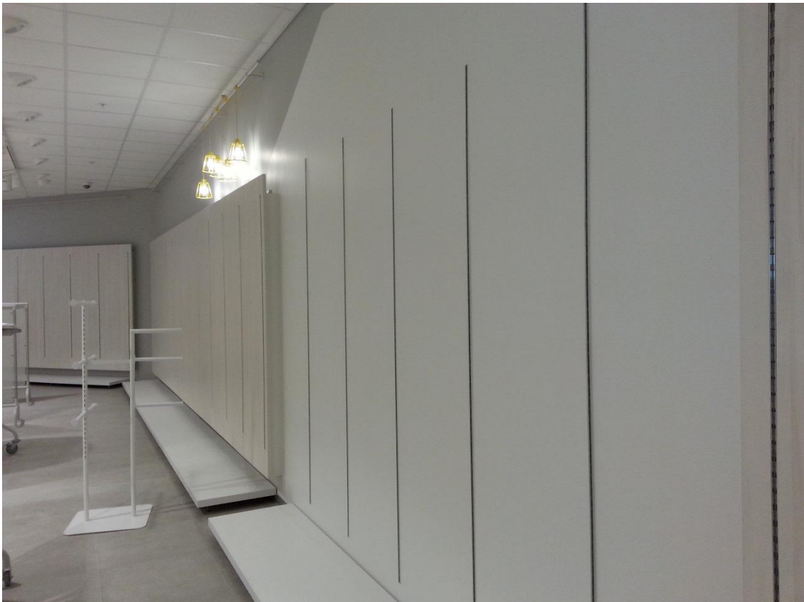
KUVA 11. Seinään upotetut kiskot kuvassa etualalla
