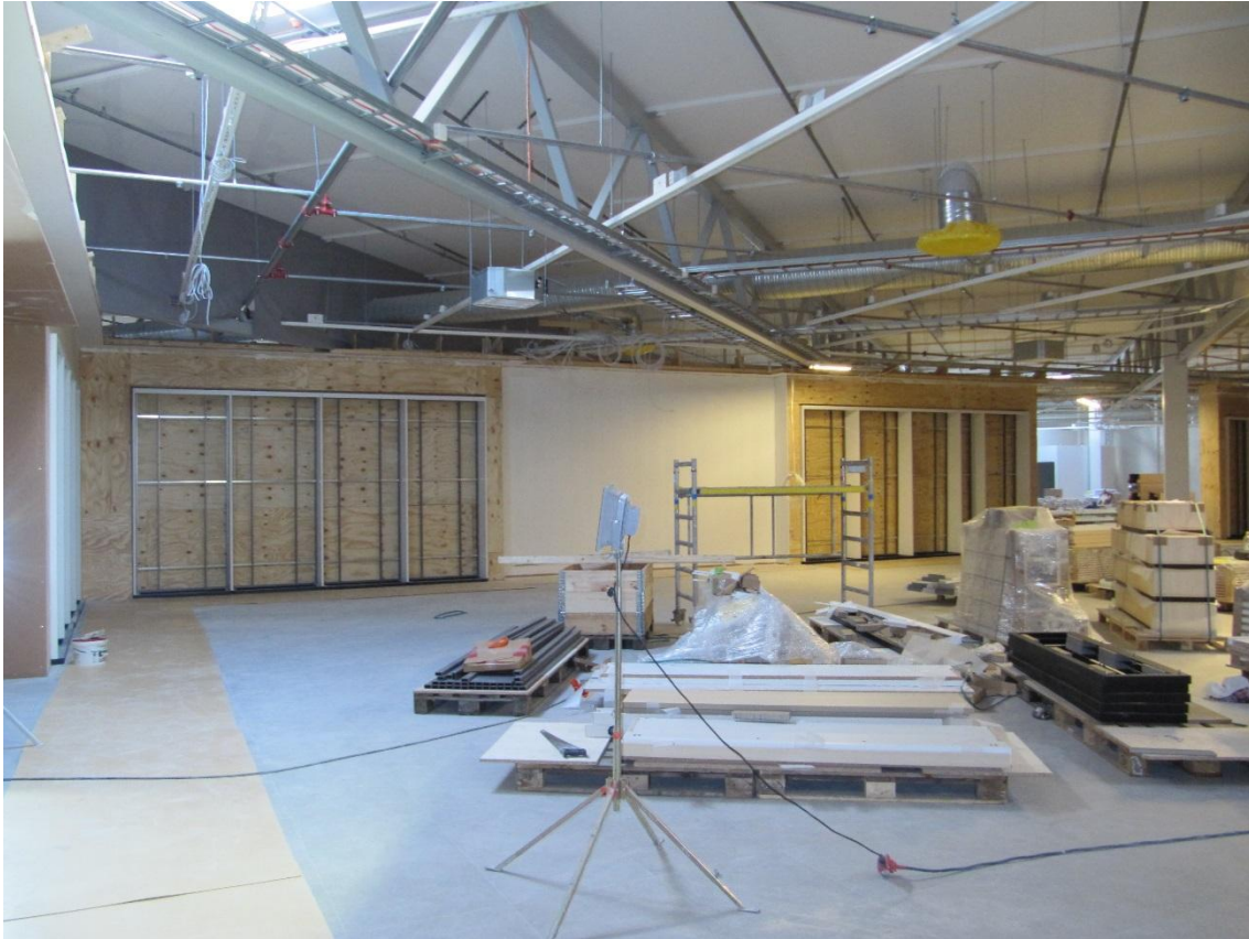
KUVA 9. Alakaton yläpuolisia rakenteita ja tekniikkaa
