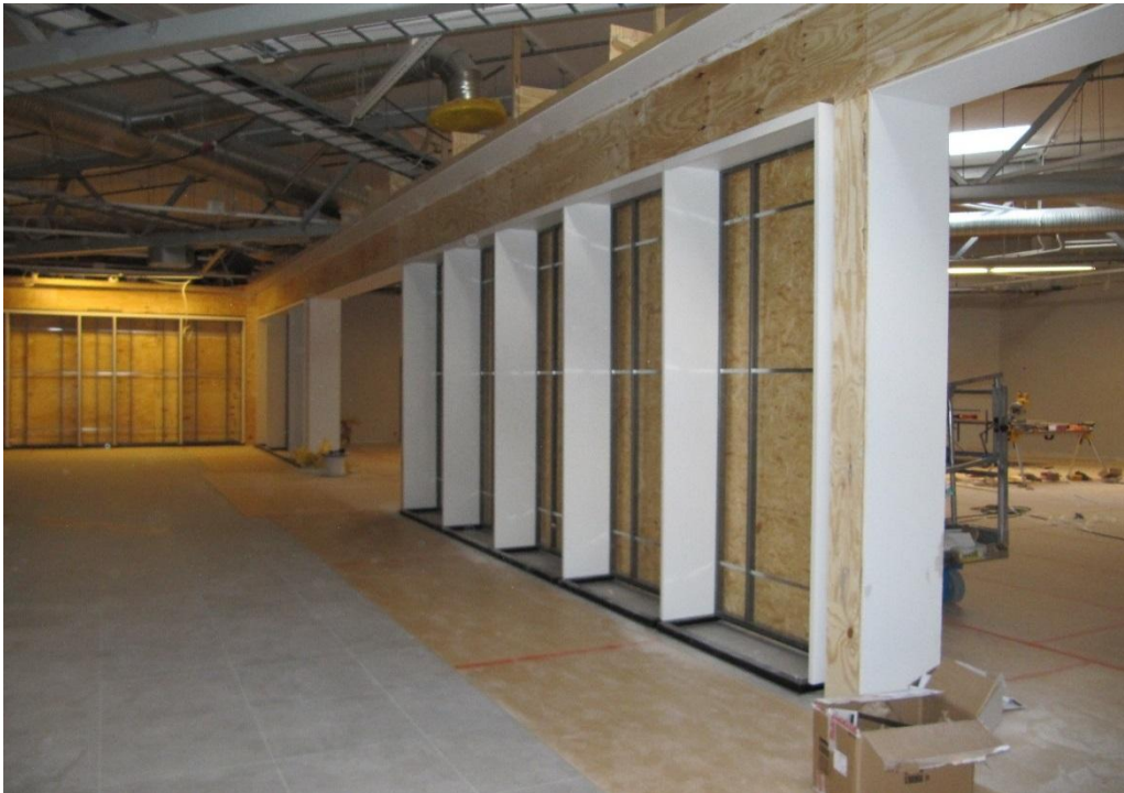
KUVA 10. Seinään upotettavat kaapit työn alla
