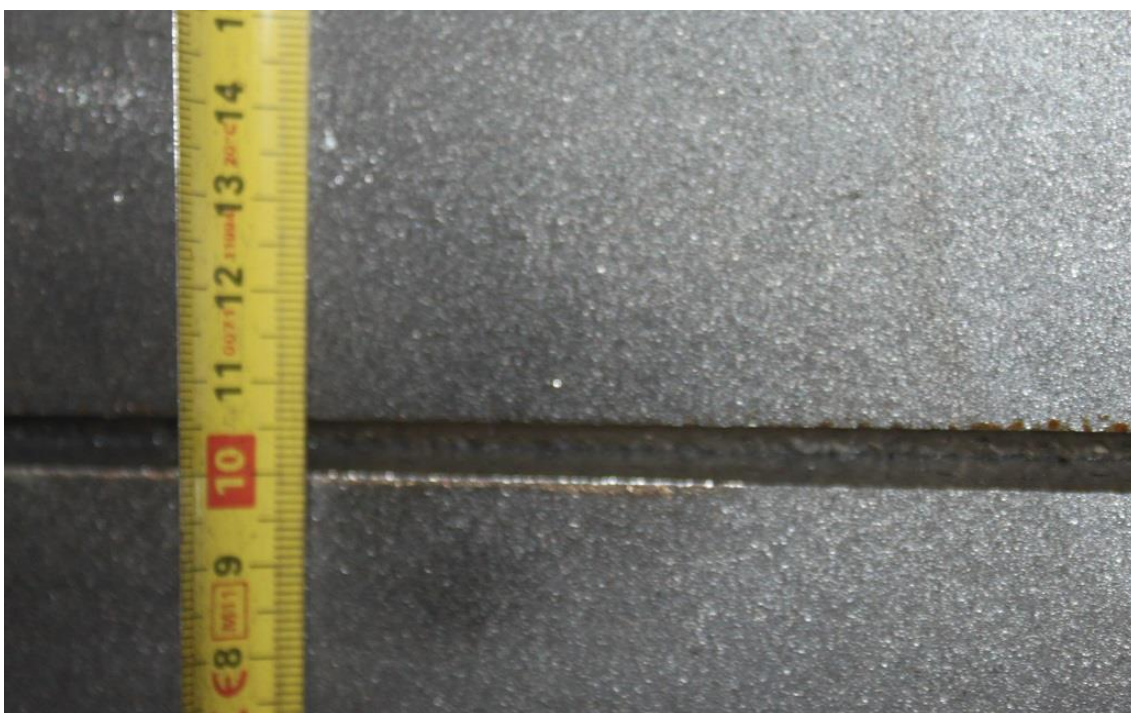
Kuva 10. Seurantaan soveltumaton railo sen kapeuden vuoksi.
