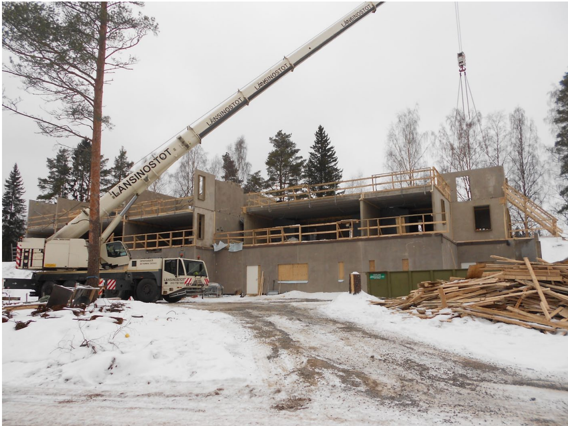
Pienkerrostalon työmaa helmikuussa 2014, kuva: Henri Ripatti
