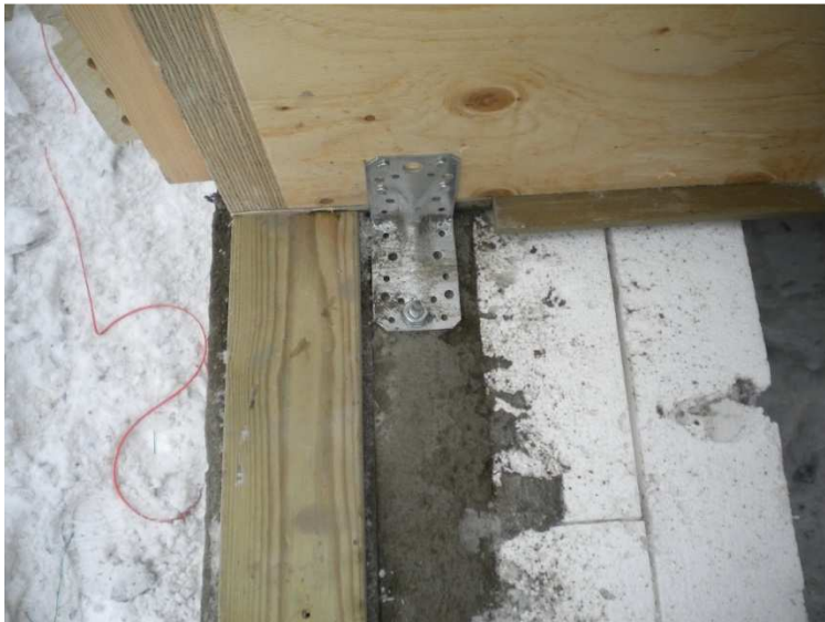
Kuva 5 Elementin kiinnitys
