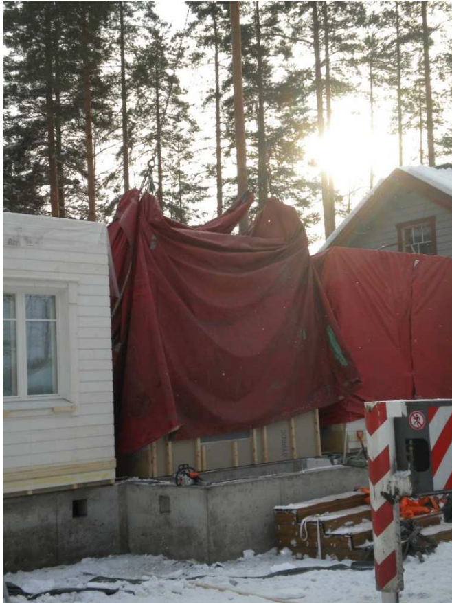
Kuva 8 Suojahupun poisto
