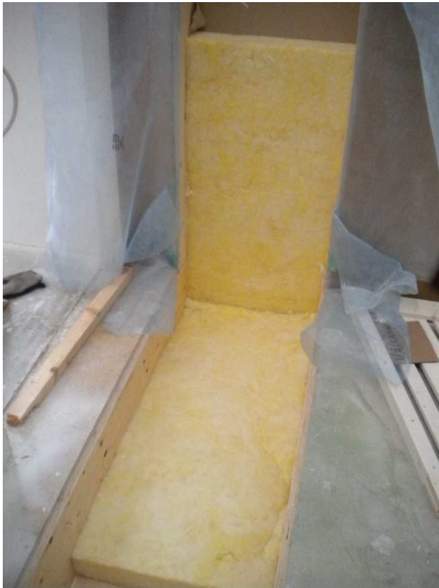
Kuva 28 Eristeiden asennus (Hintikka 2013-11-06)
