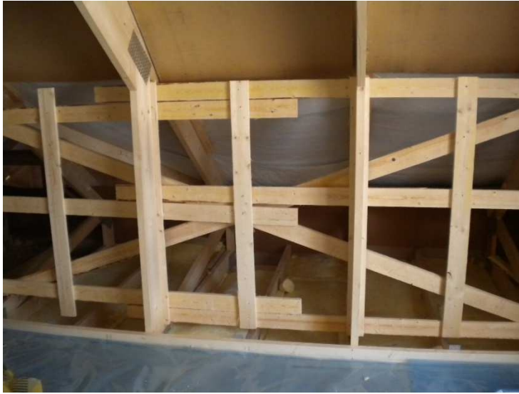
Kuva 71 Sivuseinän koolaus pystyyn (Hintikka 2013-11-13)
