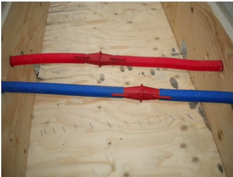
Kuva 31 Vesijohtojen suojaputkien asentaminen (Hintikka 2013-11-06)
