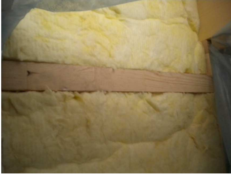
Kuva 27 Sisäverhousken kiinnityspuut (Hintikka 2013-11-06)
