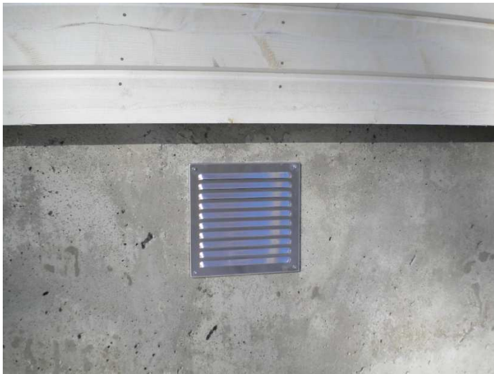
Kuva 61 Sokkelin tuuletusritilät
