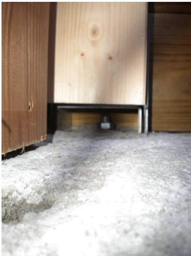
Kuva 35 Kuistin pilarien kiinnitys
