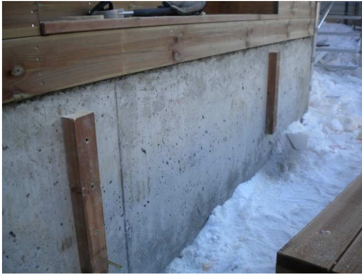
Kuva 53 Portaan kiinnityspuut
