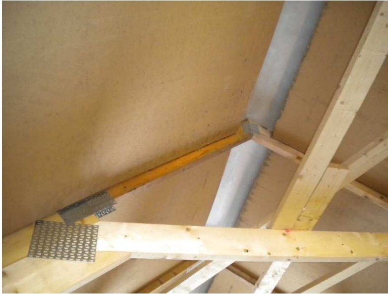
Kuva 73 Tuulensuojalevyt
