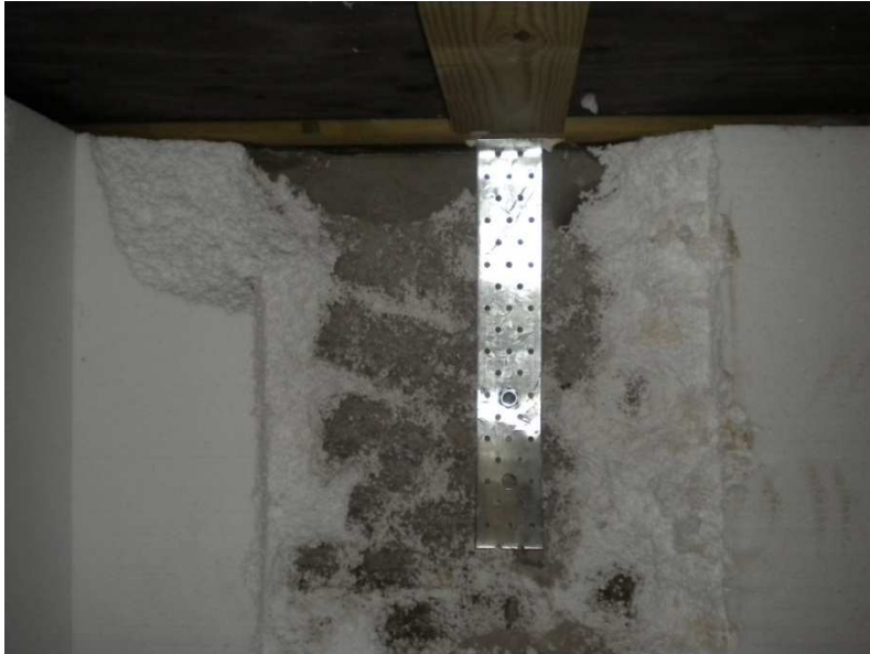
Kuva 6 Elementin kiinnitys ryömintätilassa
