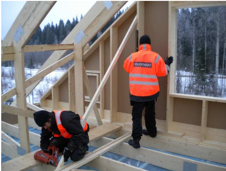
Kuva 16 Päätökolmioelementin tuenta (Hintikka 2013-11-05)
