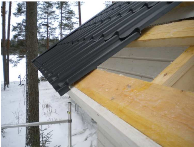
Kuva 47 Pellin ylitys räystäällä
