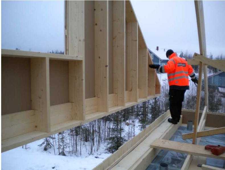
Kuva 13 Päätykolmioelementin asennus
