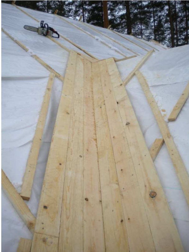
Kuva 44 Jiirin pohjan umpilaudoitus
