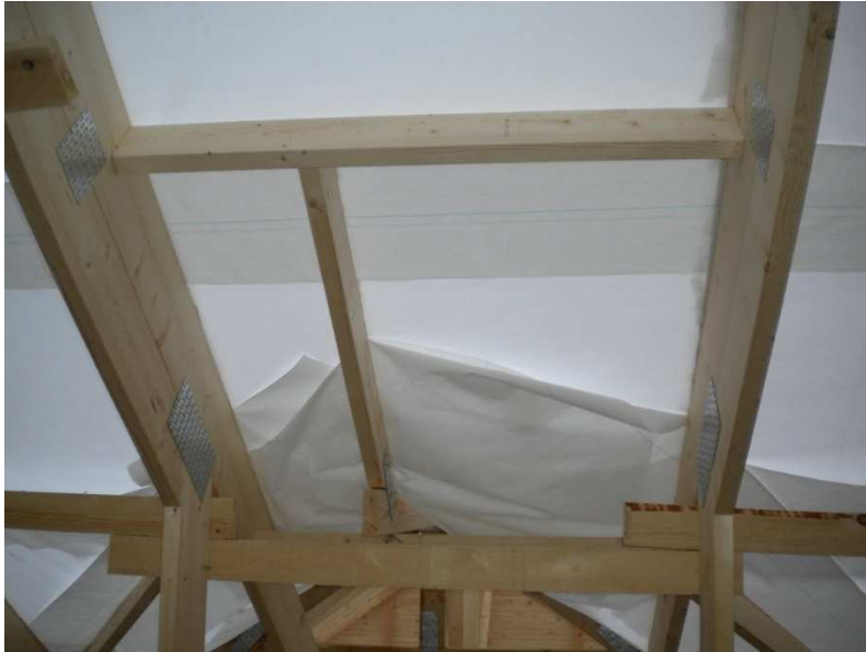
Kuva 41 Tukirunko ristikoiden välissä
