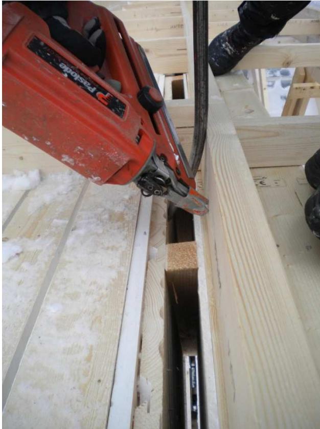
Kuva 21 Rästäselementin kiinnitys päätykolmioon (Hintikka 2013-11-05)
