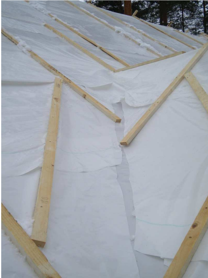
Kuva 43 Korotusrimat
