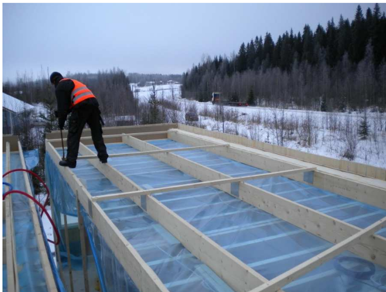
Kuva 9 Kuljetustukipuiden poisto
