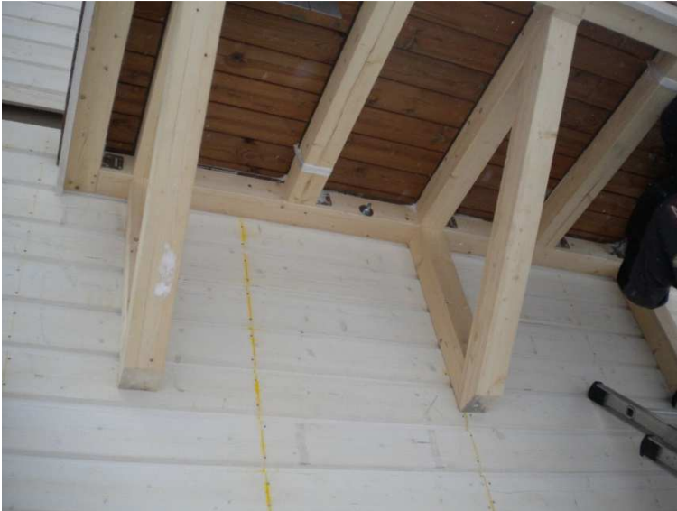
Kuva 17 Parveke-elementin asennus (Hintikka 2013-11-05)
