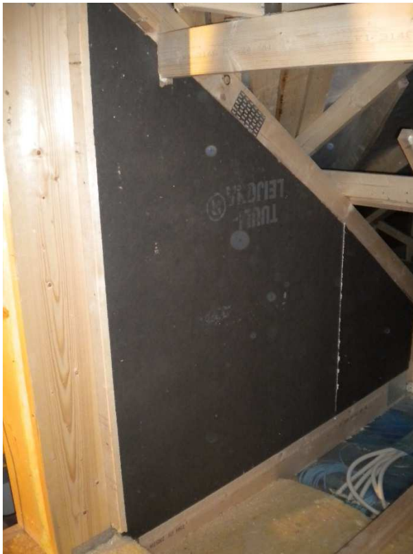
Kuva 80 Porraskuilun seinän tuulensuoja
