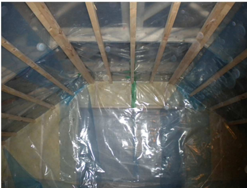
Kuva 85 Katon höyrynsulku ja koolaus
