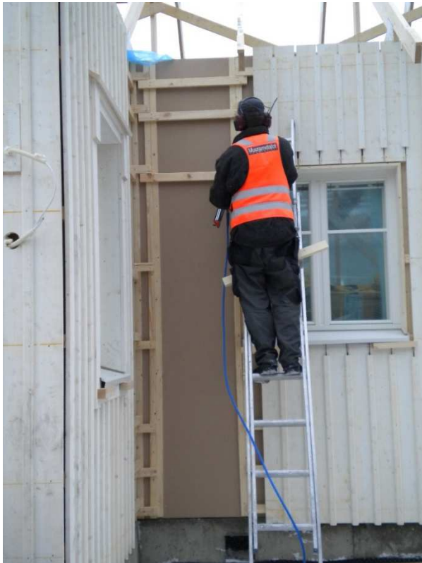
Kuva 26 Naulausriman asennus (Hintikka 2013-11-05)
