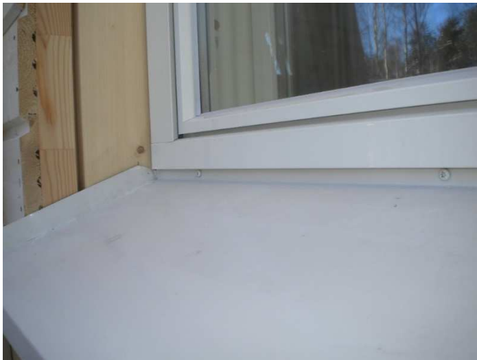
Kuva 63 Ikkunan vesipelti
