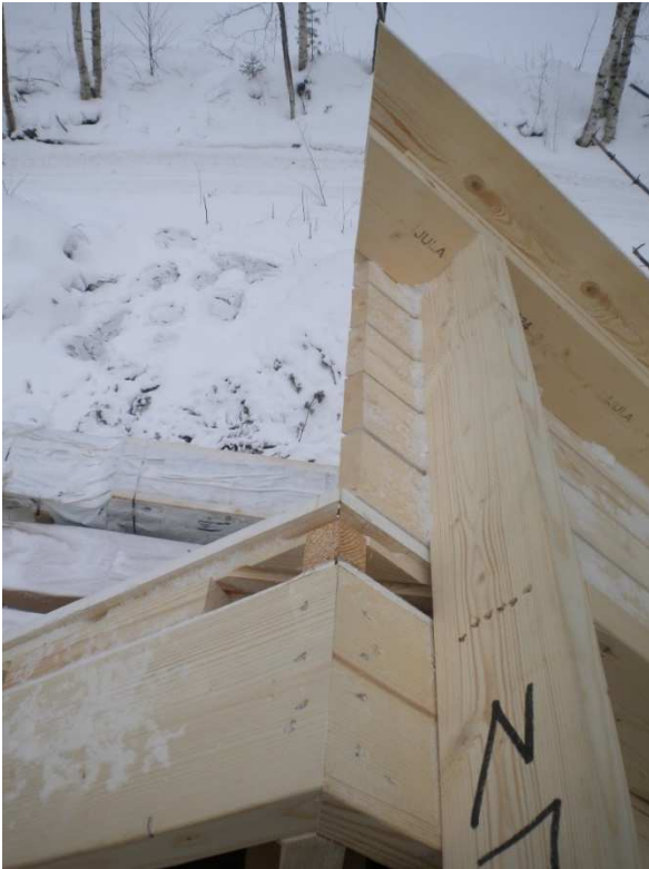
Kuva 19 Räystääselementin kohdistus (Hintikka 2013-11-05)
