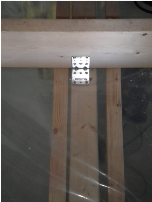
Kuva 11 Ristikon kiinnitys
