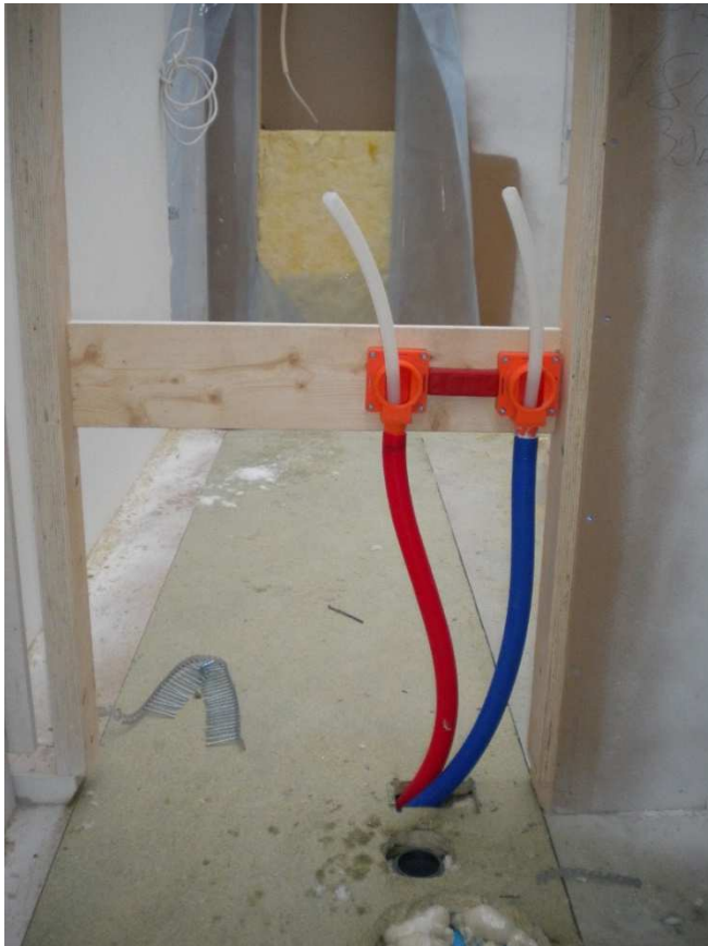
Kuva 34 Hanakulmarasian asentaminen
