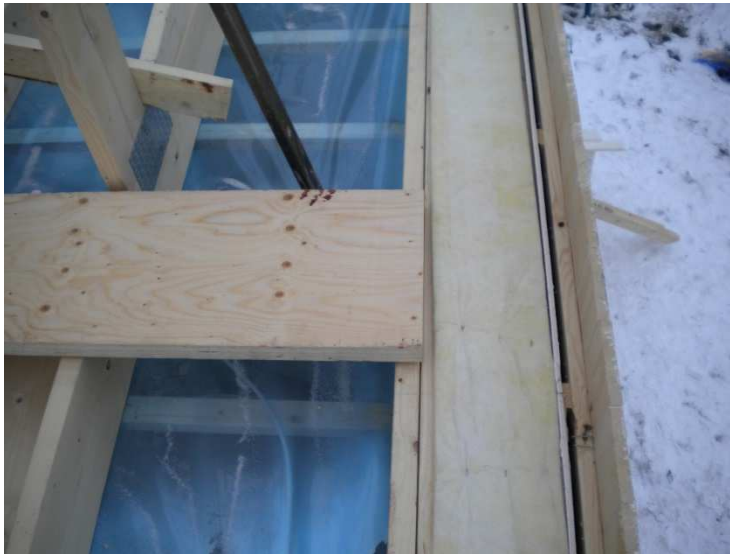
Kuva 12 Kertopuujäykisteen asennus
