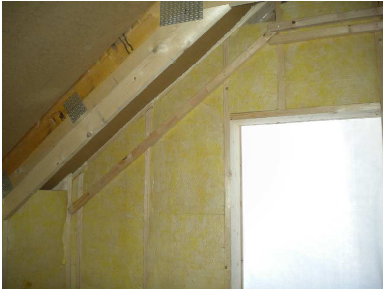
Kuva 83 Kattokoolauksen kiinnityspuut (Hintikka 2013-11-15)
