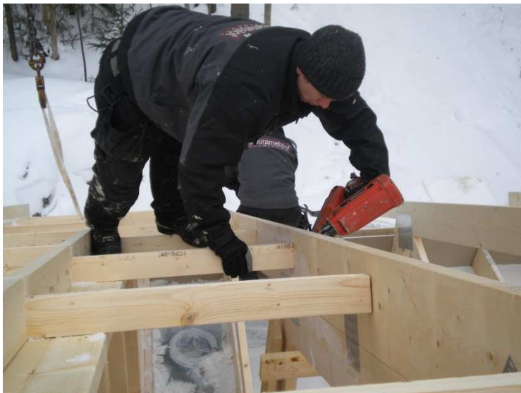
Kuva 20 Räystääselementin kiinnitys ristikkoon (Hintikka 2013-11-05)
