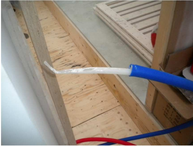
Kuva 32 Vesijohtojen asennus suojaputkiin
