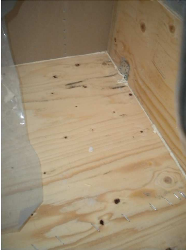
Kuva 30 Lattian homesuojattu vaneri (Hintikka 2013-11-06)
