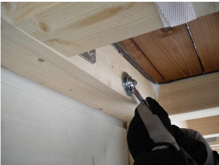
Kuva 18 Parveke-elementin kiinnitys (Hintikka 2013-11-05)
