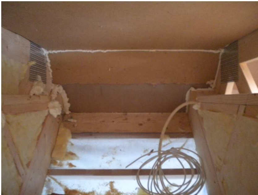
Kuva 78 Porraskuilun tuulensuojalevy
