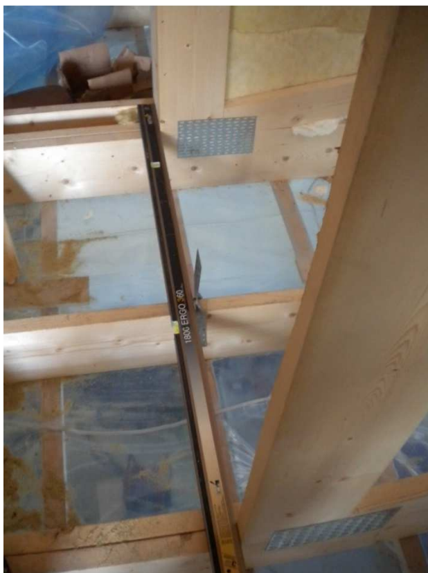
Kuva 22 Kannatuslevyjen asennus (Hintikka 2013-11-05)
