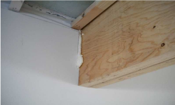
Kuva 24 Kantava välipohjapalkki
