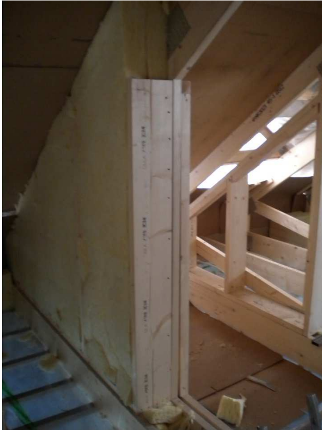
Kuva 77 Porraskuilun seinän eristeet
