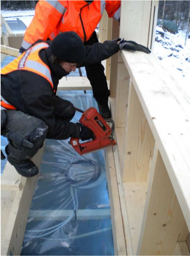
Kuva 15 Päätökolmioelementin kiinnitys (Hintikka 2013-11-05)
