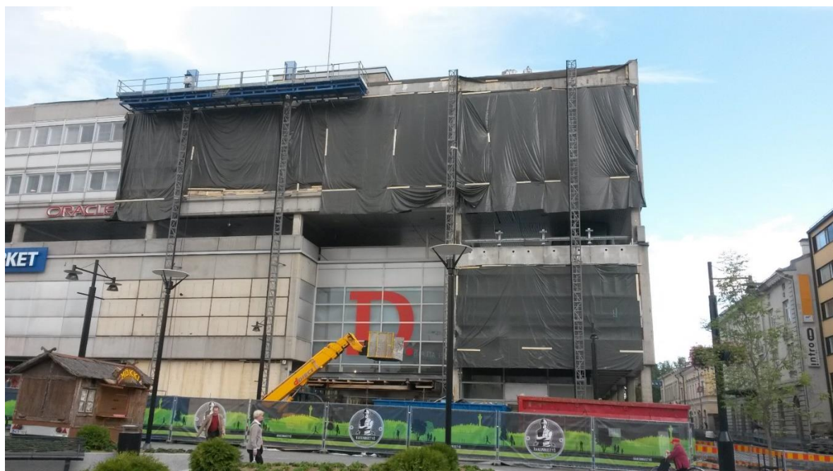
Kuva 8. Sääsuojausta jo puretulla seinänosalla. (Tiainen 2014-07-04)
