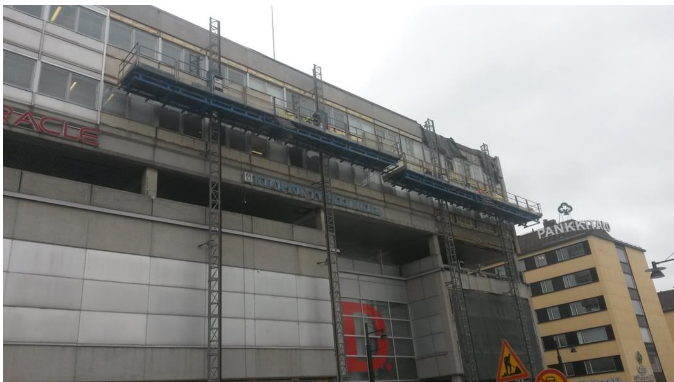
Kuva 6. Mastonostimet Puijonkadun puolella. (Tiainen 2014-07-03)
