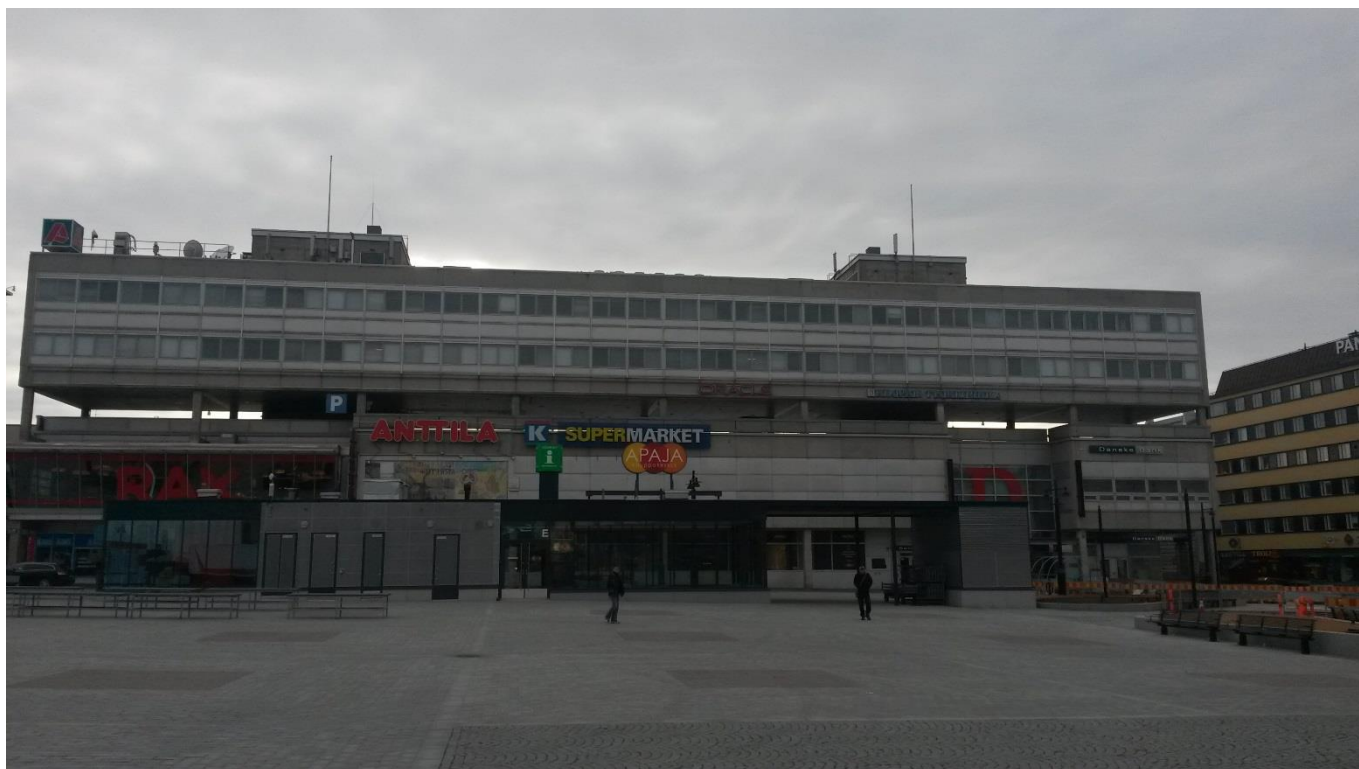
Kuva 1. Anttila ennen julkisivun purkamista (Tiainen 2014-05-16)
