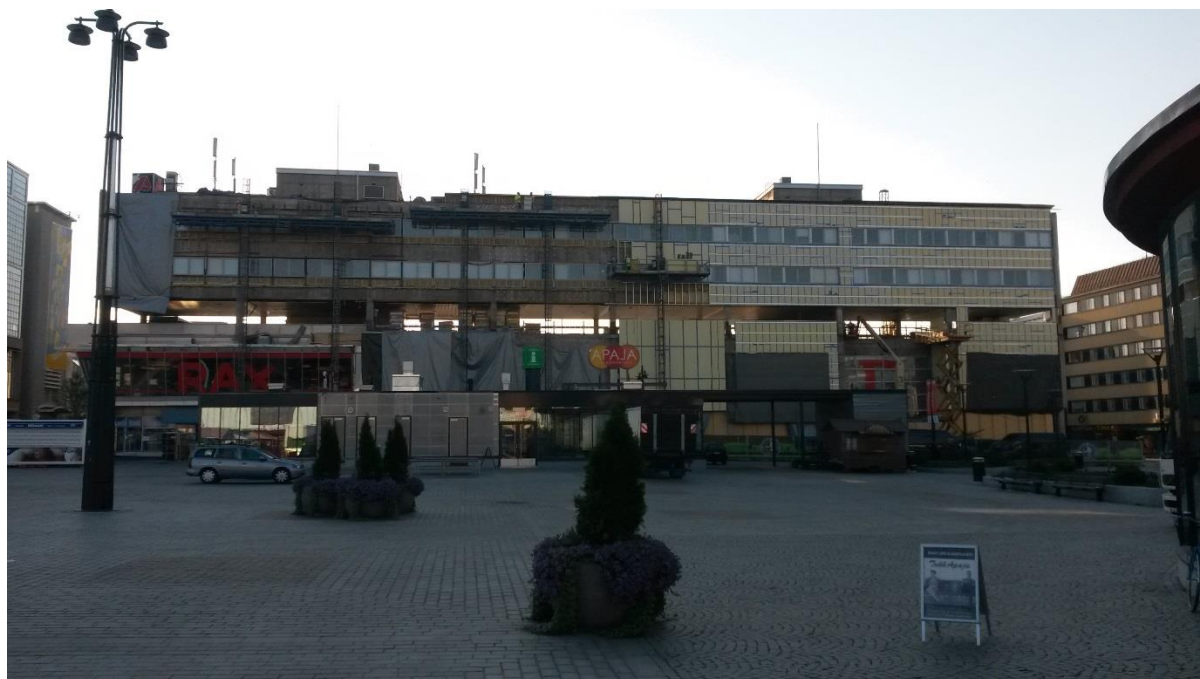
Kuva 4. Puijonkadun puolella uutta seinärunkoa on asennettu n. 50 % (Tiainen 2014-08-06)
