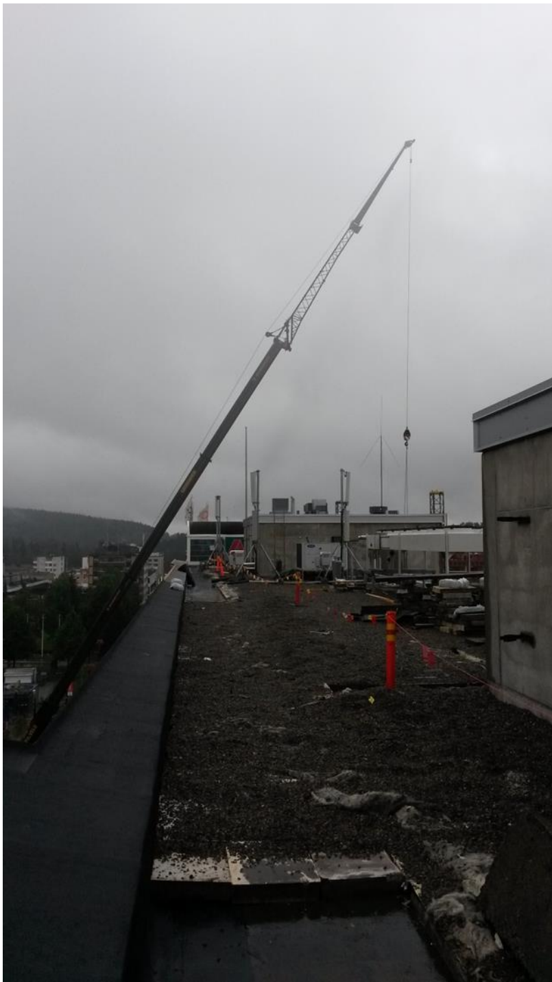
Kuva 7. Julkisivuelementtien nostoa autokannelta talon yli. (Tiainen 2014-08-26)
